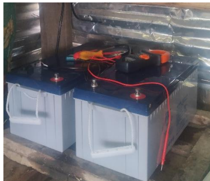
Baterías Conectadas en Serie
