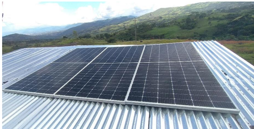
Instalación de Paneles Solares
