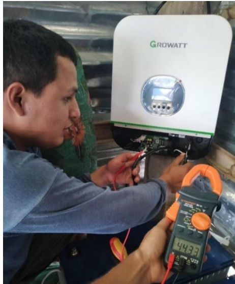
Instalación del Inversor GROWATT
