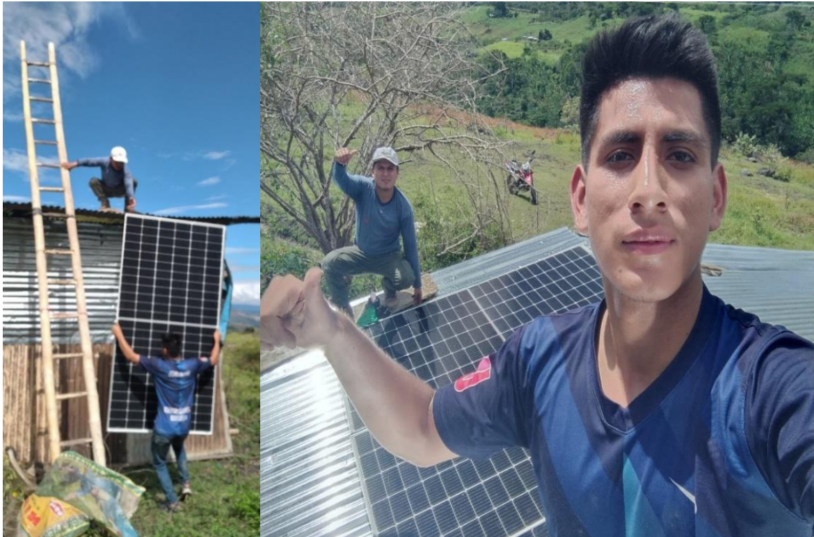
Instalación de Paneles Solares
