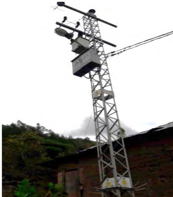
**Figura 10 Ferretería eléctrica en mal estado**
