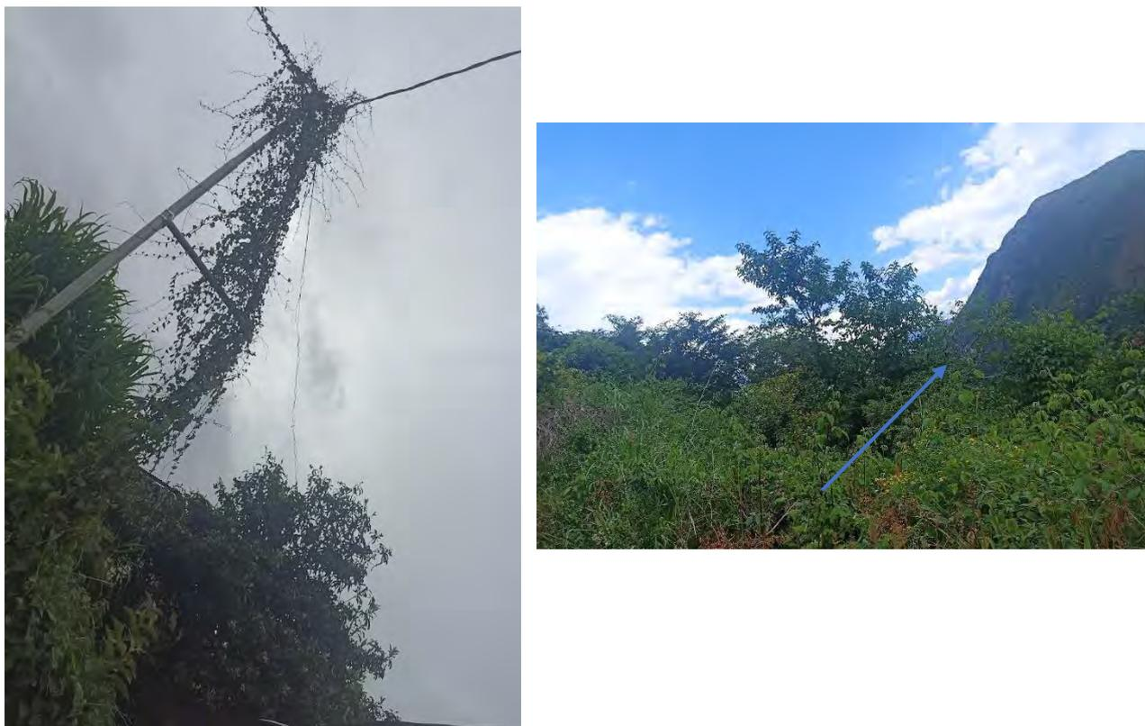
El mal estado de las acometidas eléctricas existentes genera serios inconvenientes en la distribución de energía, en campo se evidencio problemas en las conexiones ya que estaban deterioradas, el aislamiento dañado y los conductores se veían corroídos mismos que representan un riesgo tanto para la eficiencia del suministro como para la seguridad de las personas. En estas condiciones se pueden ocasionar interrupciones, sobrecalentamientos o incluso incendios eléctricos.
