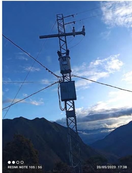
**Figura 7 Aisladores tipo PIN en mal estado.**
