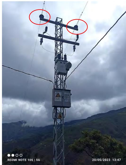
**Figura 8 Seccionamientos deteriorado a raíz del tiempo**
