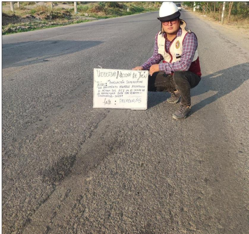
**Figura 59.** *Falla: Pulimiento de agregados.*
