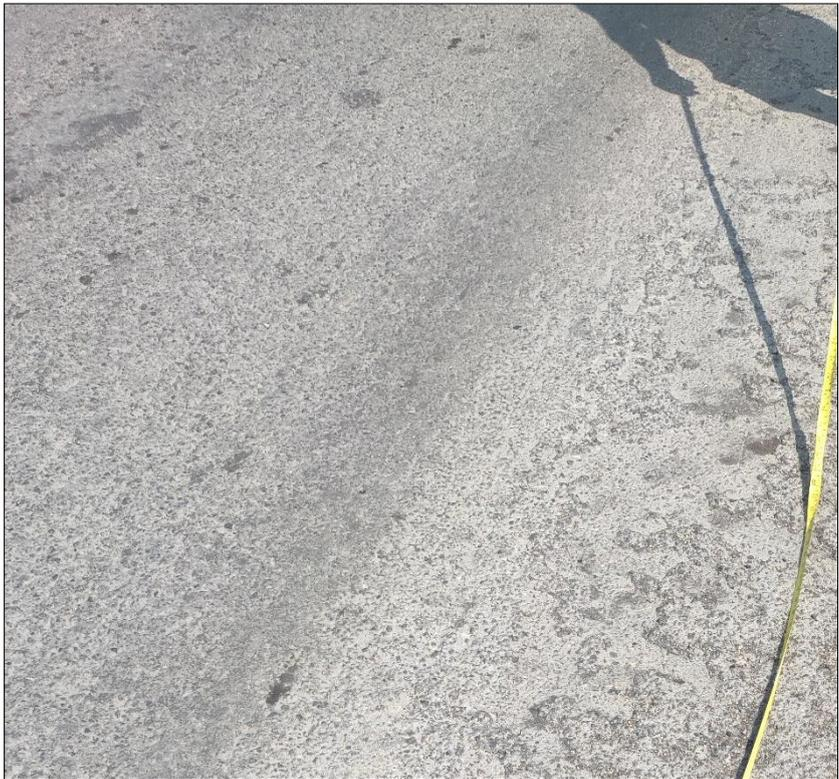
**Figura 42.** *Falla: Fisuras en bloque.*
