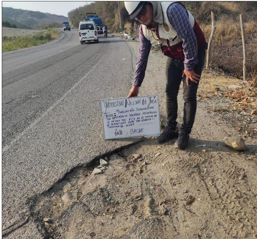
**Figura 63.** *Falla: Desprendimiento de agregados.*
