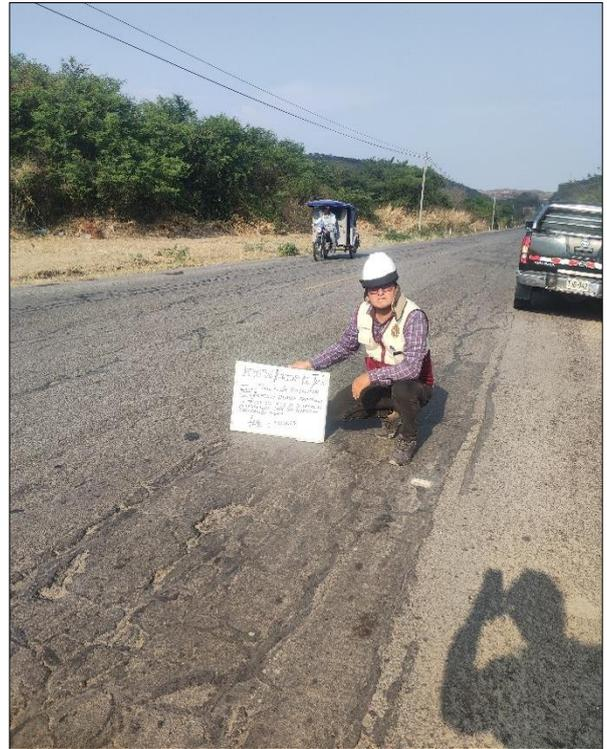
**Figura 43.** *Falla: Fisuras en bloque.*
