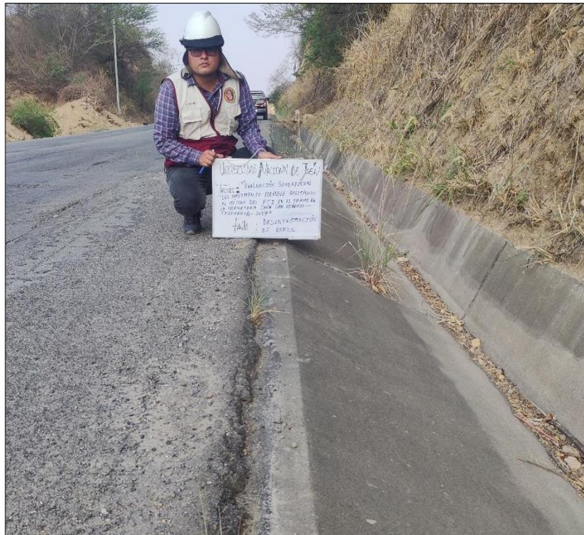
**Figura 51.** *Falla: Grietas longitudinales y transversales.*
