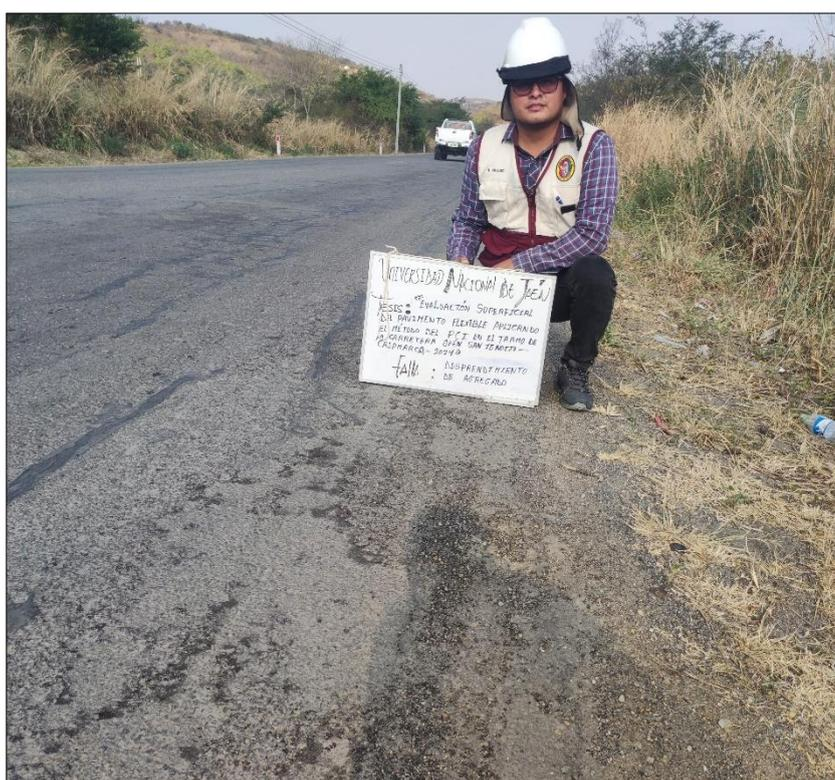
**Figura 66.** *Falla: Desprendimiento de agregados.*
