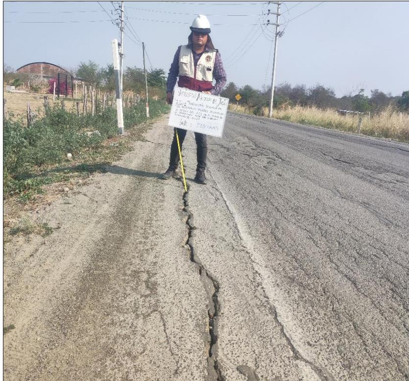
**Figura 53.** *Falla: Grietas longitudinales y transversales.*
