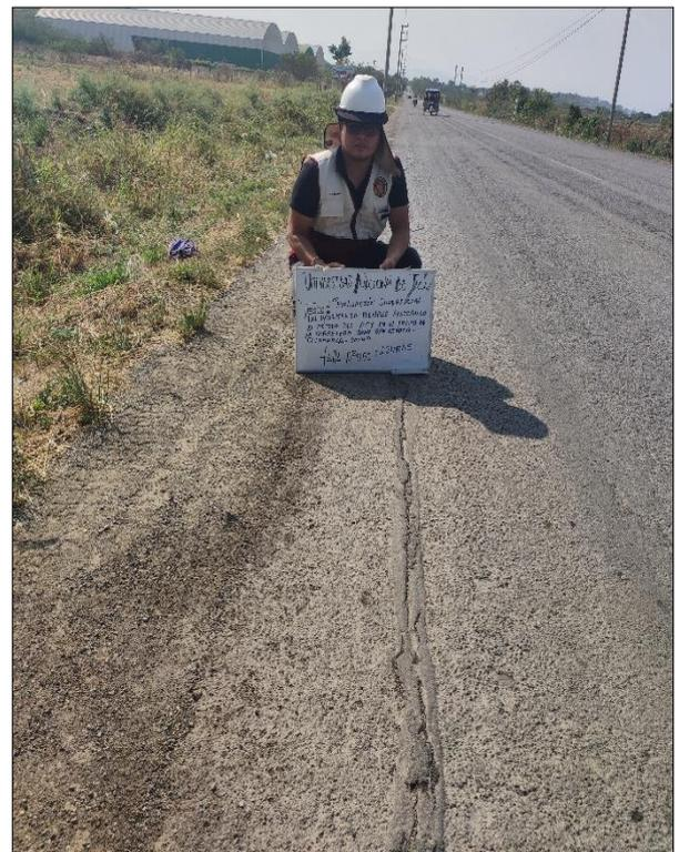
**Figura 52.** *Falla: Grietas longitudinales y transversales.*
