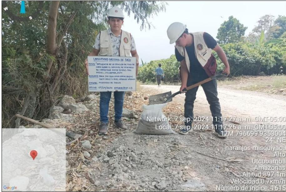
En la figura 42, se observa el proceso de extracción de la muestra de afirmado para la exploración N° 03 de 1.0m de ancho x 1.0m de largo x 0.20m de profundidad.
