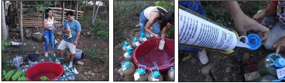
Figura 10. Instalación de los 13 biodigestores.
