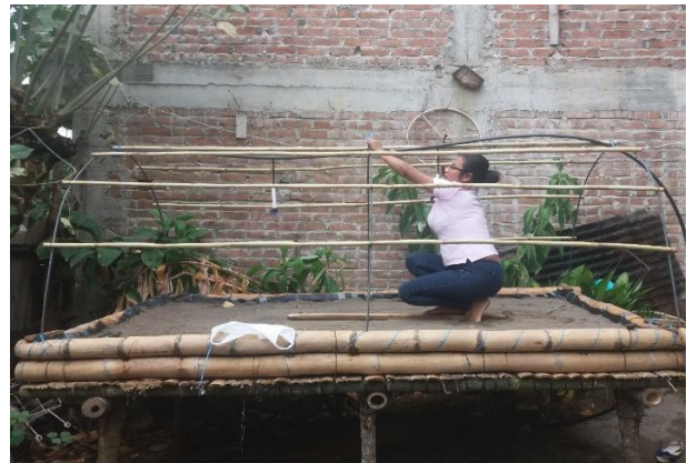
Imagen 7: Instalación del sistema de riego por nebulización
