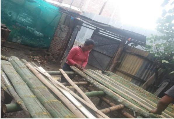
Imagen 4: Construcción de la base del micro túnel de propagación, utilizando bambú, madera y fierro.
