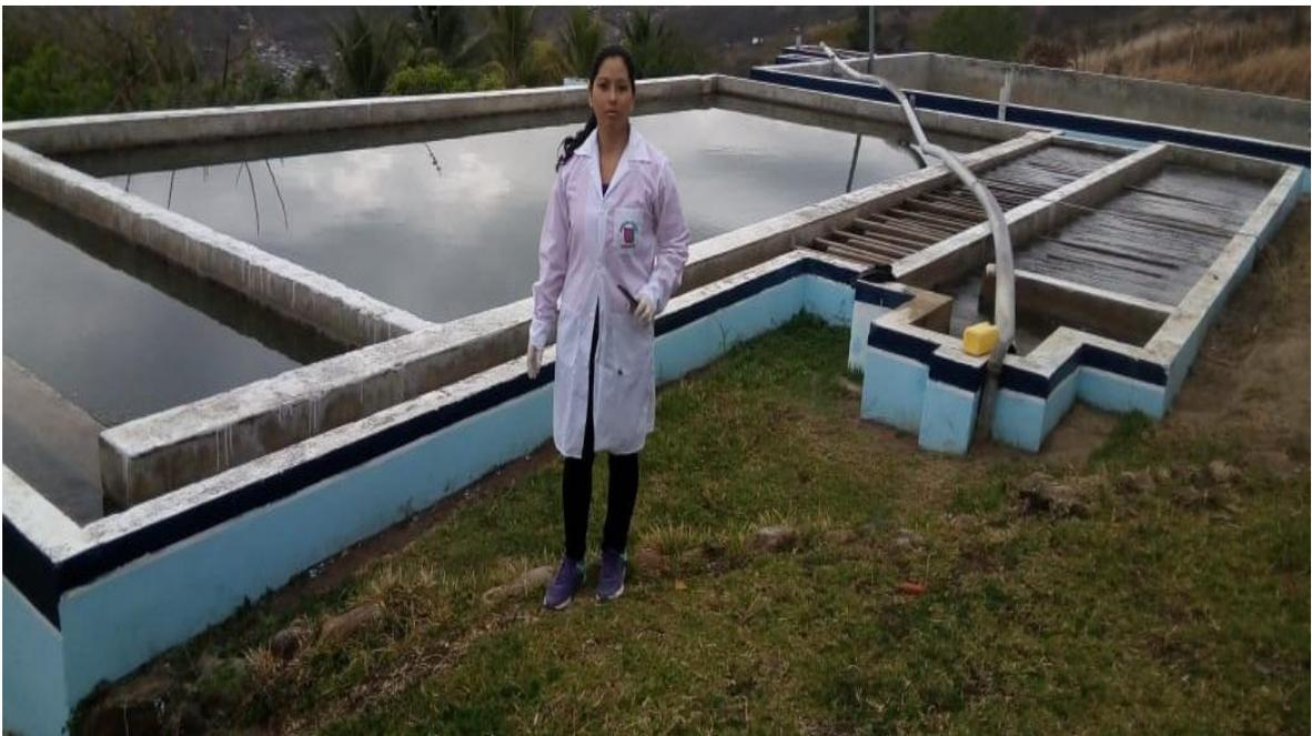
*Foto 3: Planta de tratamiento de agua del sector de Fila Alta, consta de 1 poso de sedimentación y un poso de filtración y 2 reservorios uno de  $362 \text{ m}^3$  y otro de  $252 \text{ m}^3$ .*
