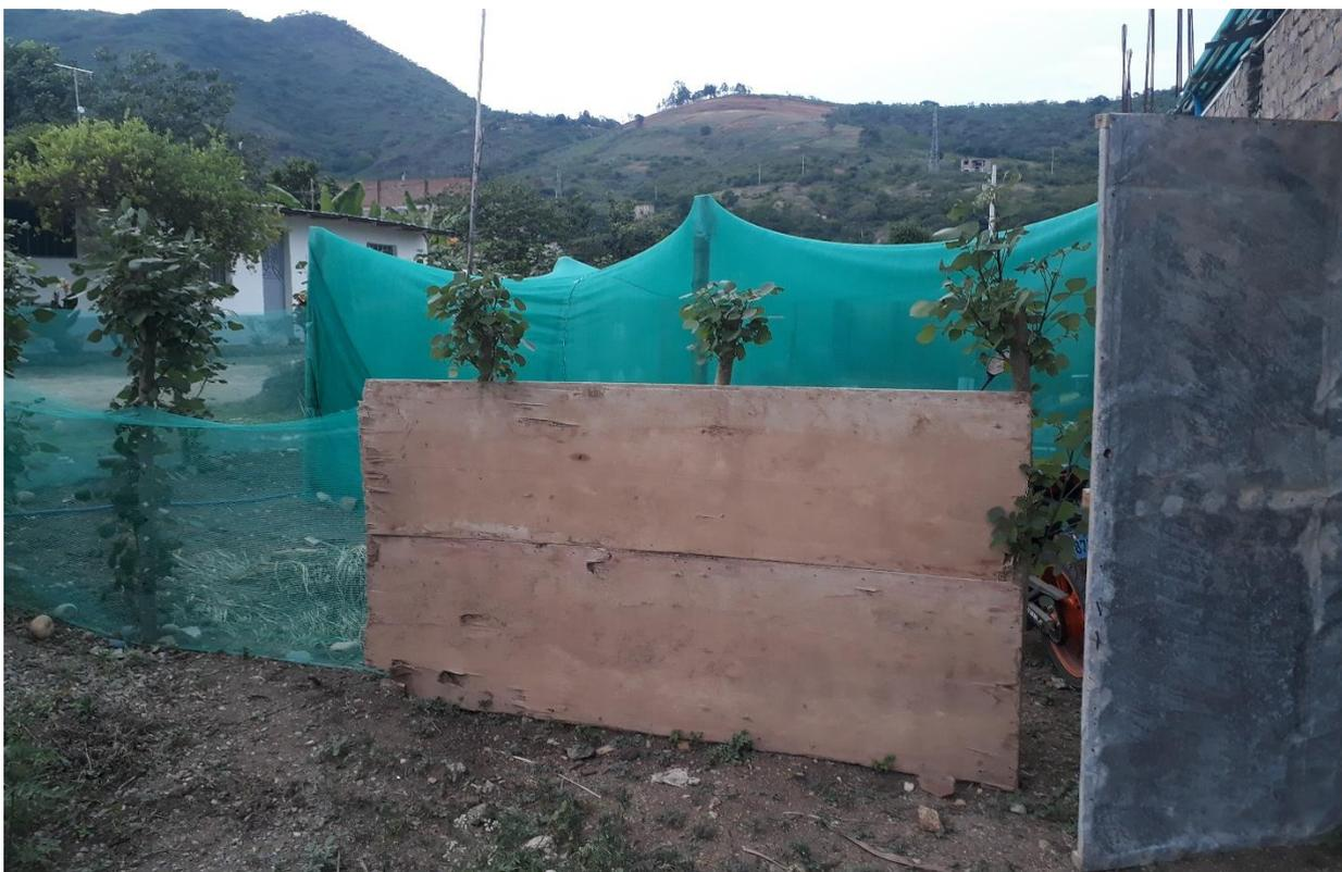
**Fotografía 12.** Cercado del perímetro e instalación de la malla Raschel.
