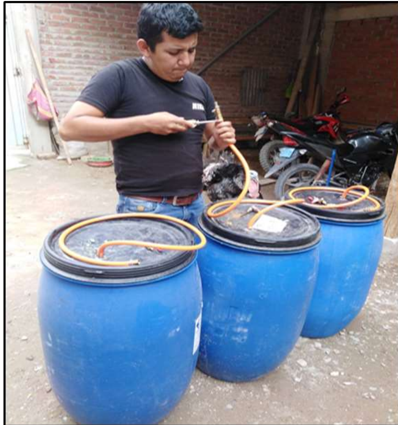
Imagen 2: Instalación del biodigestor
