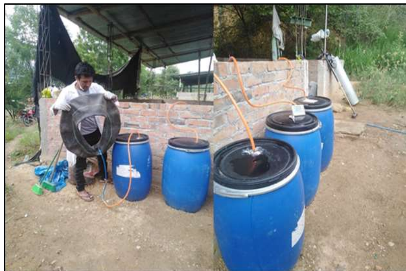
Imagen 7: Instalación de gasómetro o cámara de almacenamiento
