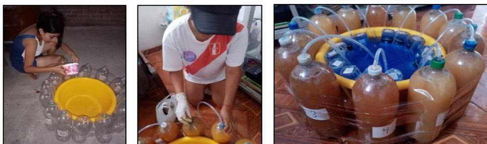
**Figura 16. Instalación del piloto para anaerobiosis del agua miel de café.**
