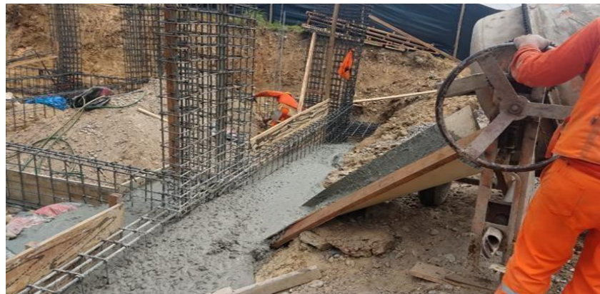
Figura N° 4. Llenado de columnas
