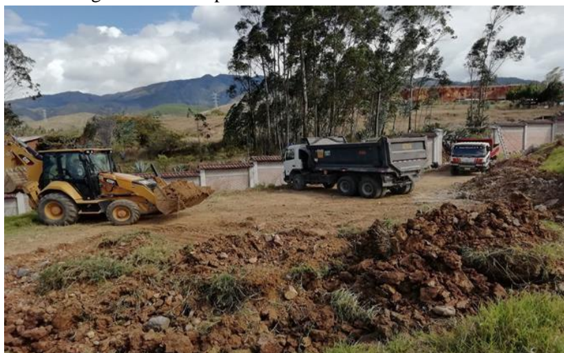
Figura N° 6. Limpieza de terreno
