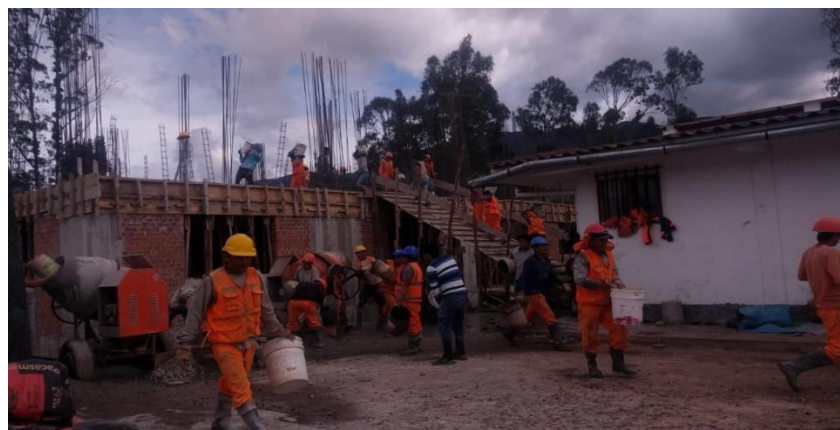
Figura N° 5. Llenado de techo
