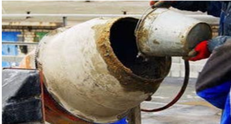
Figura N° 3. Consumo de agua para realizar la mezcla de concreto
