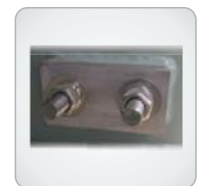
Bornes de puesta a tierra
