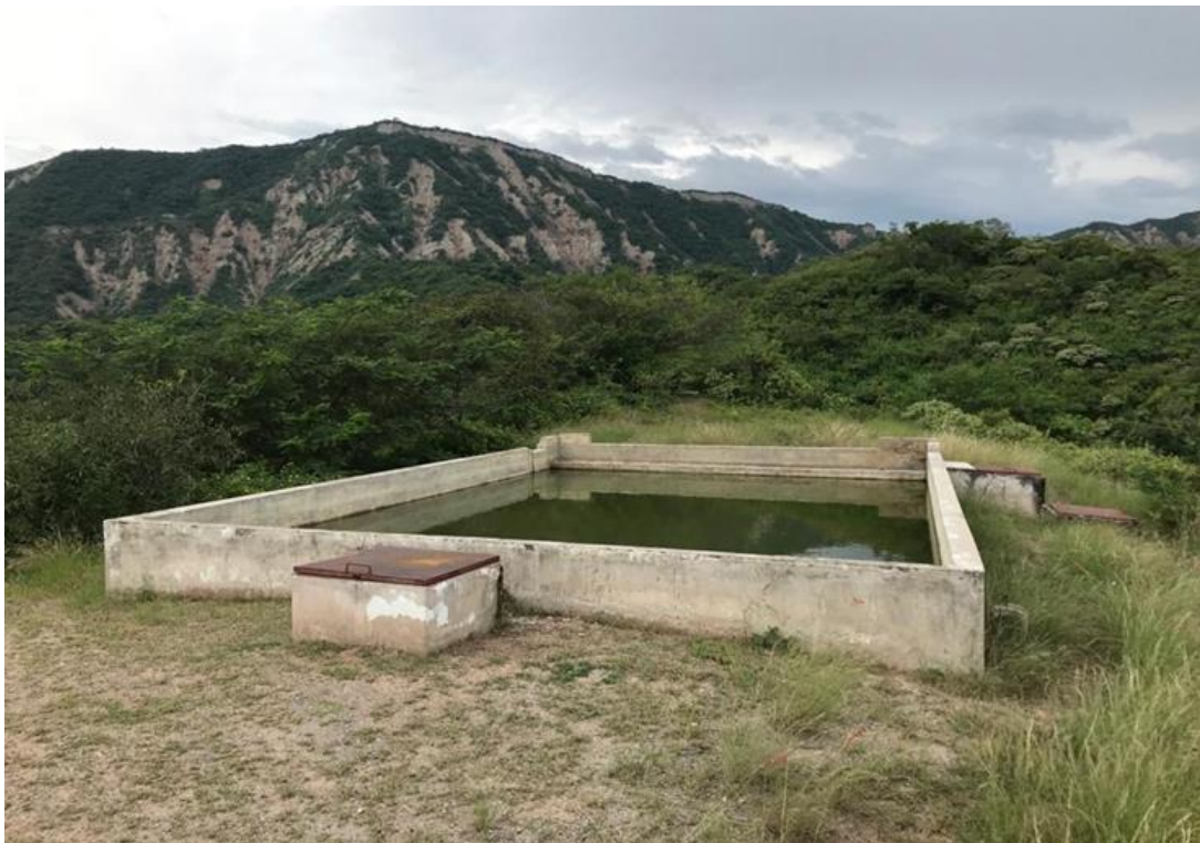
Figura 10. Primer pozo de la planta de Tratamiento.
