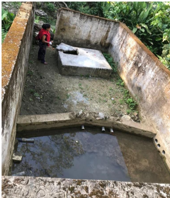
figura 9. Captación de agua del manantial "Chonza Laguna".
