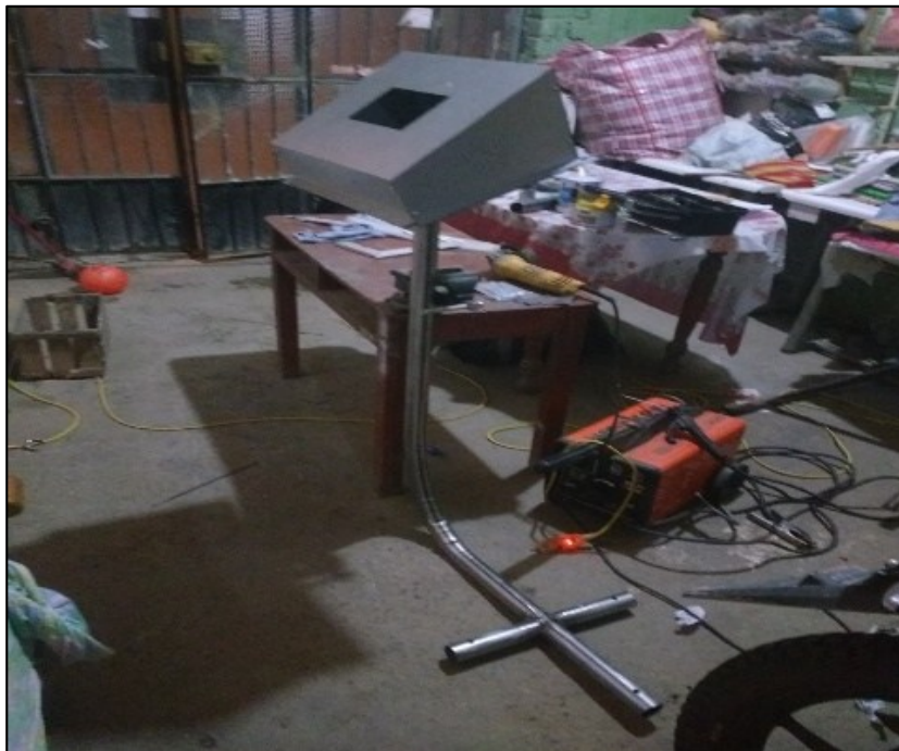
Figura 55 Soldado y perforado para anclaje de tablero y brazo. Fuente : Elaboración propia.
