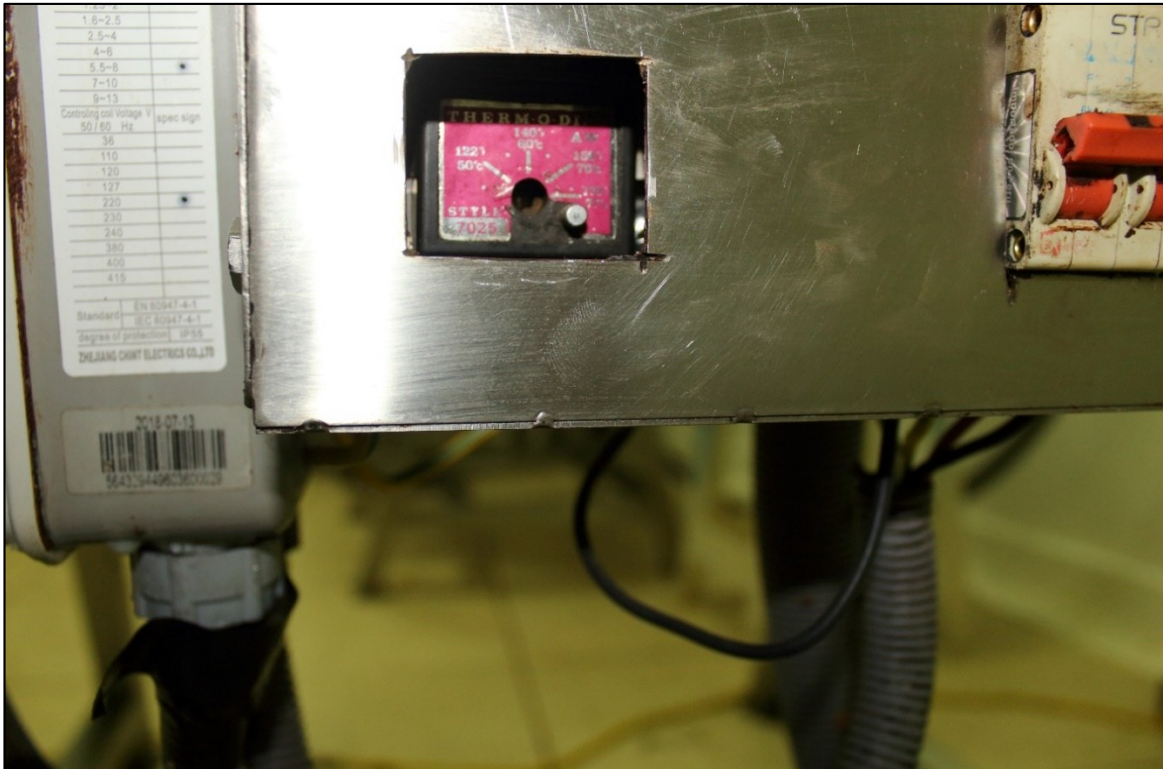
Fotografía 8 Termostato sin potenciómetro de regulación funciona como un interruptor abierto. Fuente : Elaboración propia.
