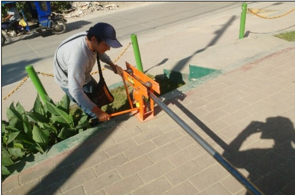
Figura 54 Doblado de tubo galvanizado para construir brazo de soporte para tablero HMI. Fuente : Elaboración propia.
