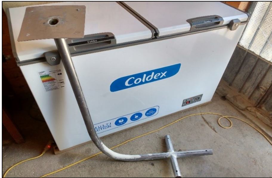
Figura 56 Tratamiento de masillado y pintado de brazo de soporte. Fuente : Elaboración propia.
