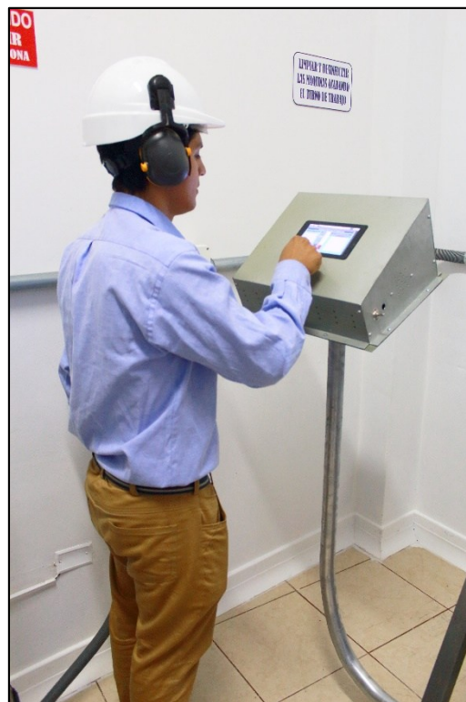
Fotografía 21 Guardando historial de temperatura utilizando HMI táctil. Fuente : Elaboración propia.
