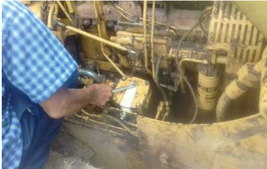
Cambio de bombas hidráulicas
