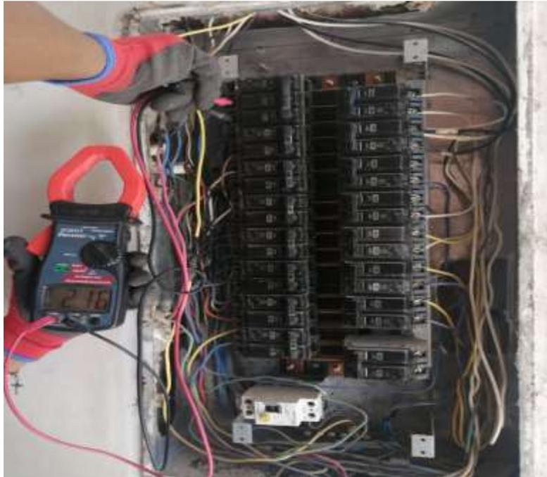
*Figura 31 Diagnostico del sistema eléctrico*
