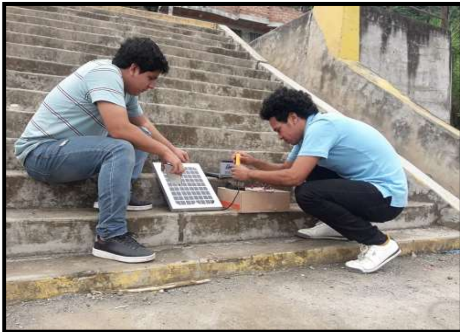
Figura 36. Instalación de los componentes fotovoltaicos. Fuente: Elaboración propia
