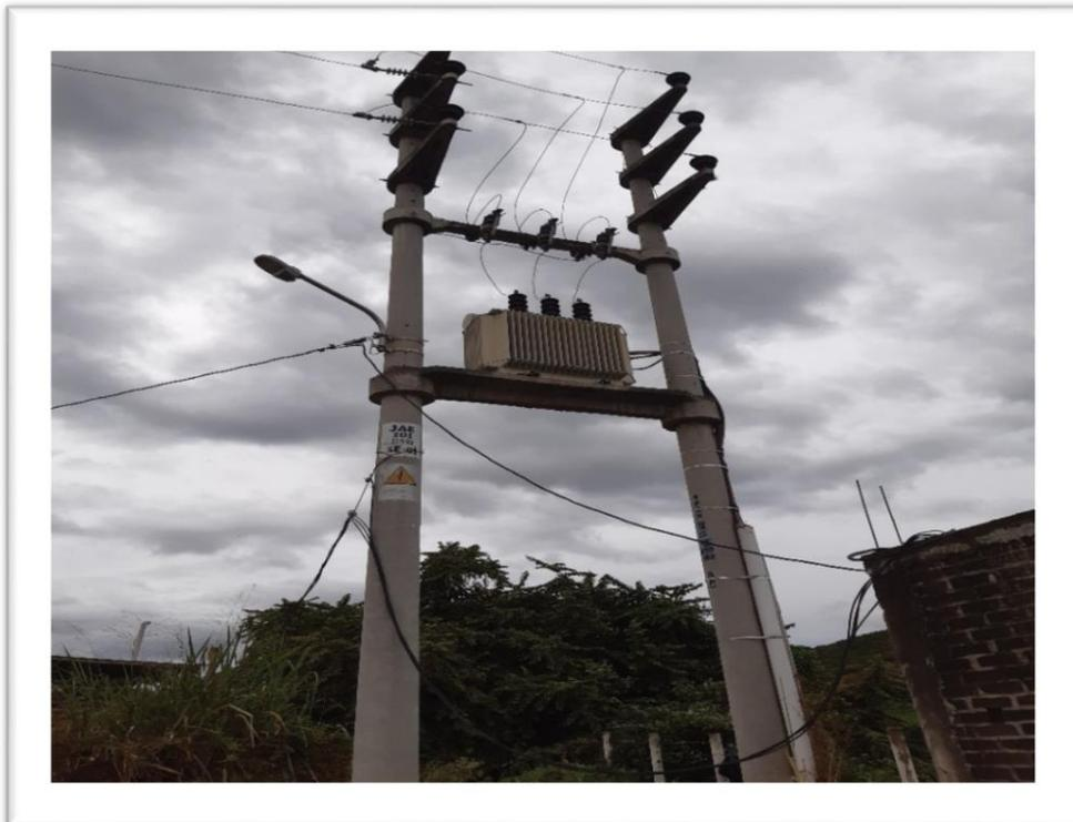
*Figura 34 Transformador de Distribución de 400 kVA*
