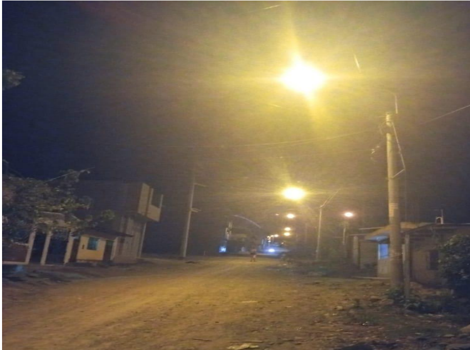
Figura 24. Configuración del alumbrado público del sector. Fuente: elaboración Propia.
