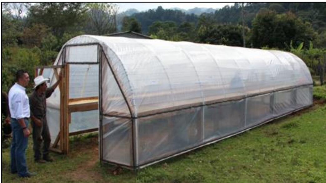
Figura 13. Imagen referencial de una cubierta de la cámara De secado
