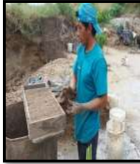
Figura 15. Amasado y llenado de gaveras en fábrica artesanal
