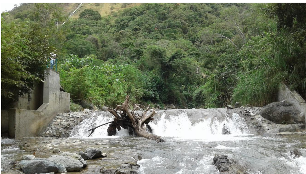
Descripción: Sección aguas abajo de la bocatoma -03, ambos márgenes.
