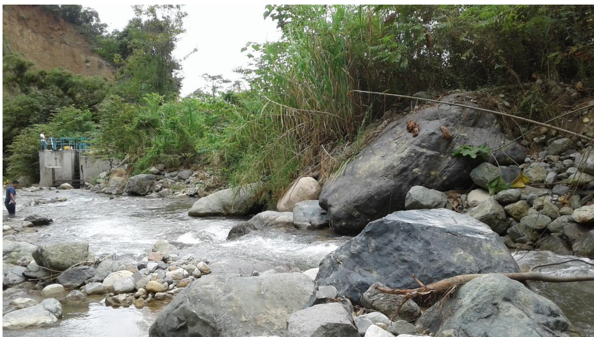
Descripción: Cauce principal; progresiva 110; margen izquierdo.
