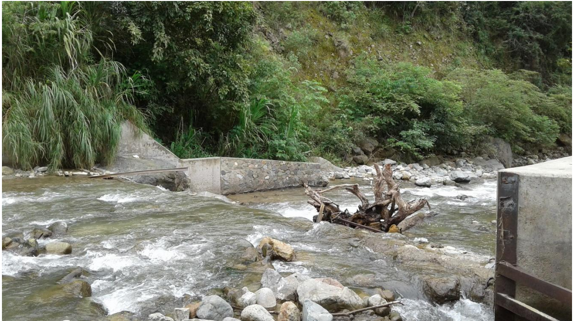
Descripción: Bocatoma del río Amojú – sector La Corona Jaén-Cajamarca.
