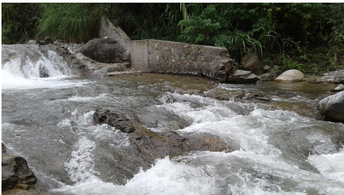
Descripción: Sección aguas abajo de la bocatoma, margen derecho.
