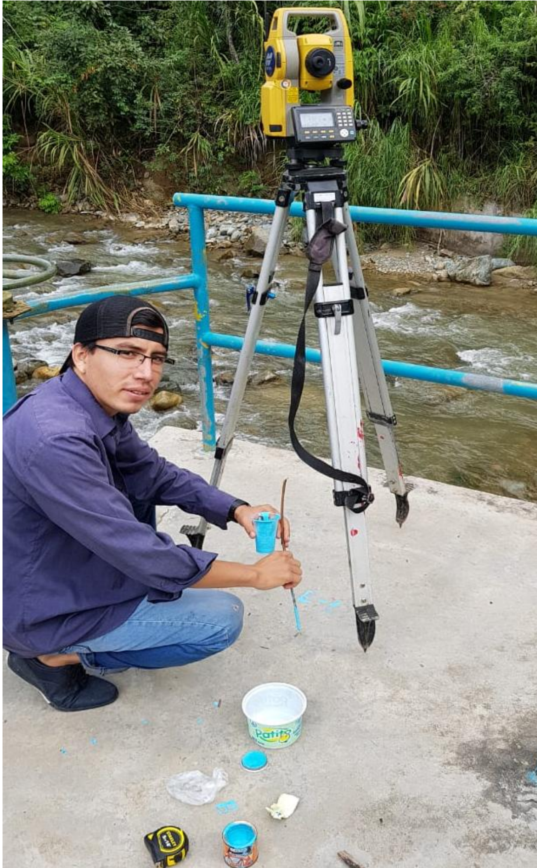
Descripción: Levantamiento topográfico – estación total.
