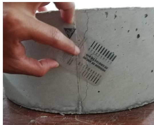
Figura 79. Medición de grietas
