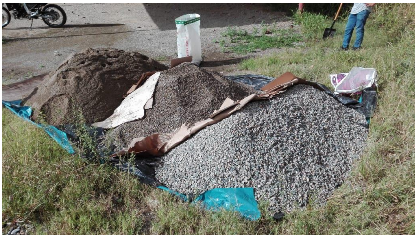
Figura 5. Agregado fino y grueso almacenado
