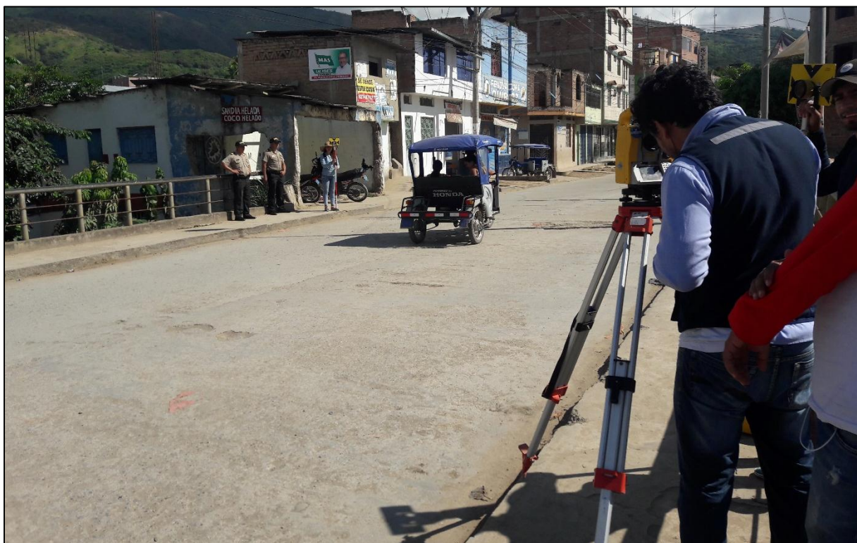
Trabajo en campo de topografía con estación total, toma de detalles del puente Orellana, con la protección policial de la Policía Nacional del Perú – Jaén.
