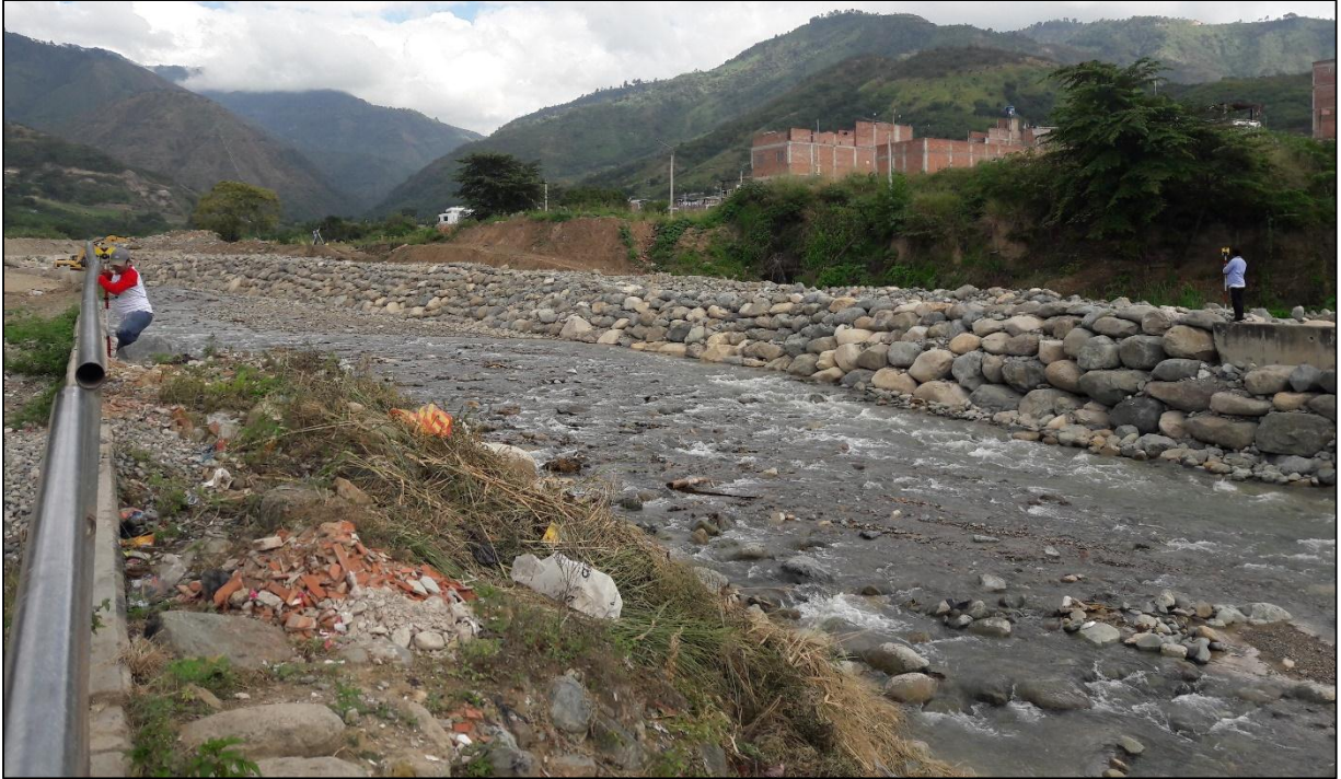
En la imagen se visualiza el trabajo en campo de topografía con Estación total del Sector El Parral. Fuente: Elaboración propia
