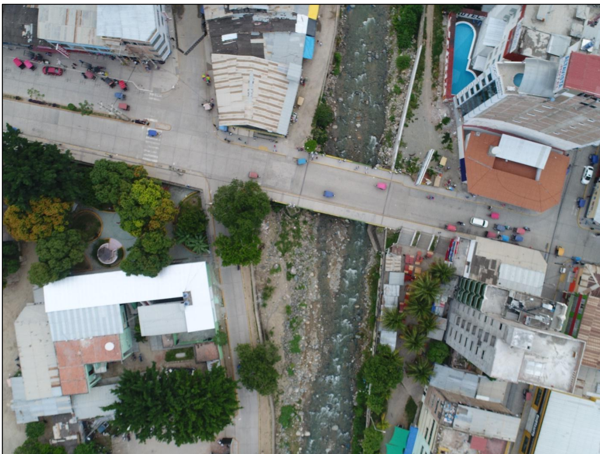
Figura 19. Puente Mesones Muro desde una vista aérea.
