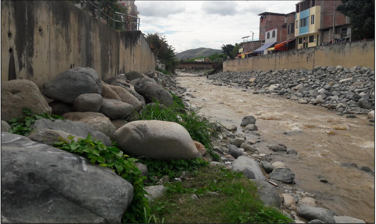
En la zona céntrica de la ciudad, cuenta con Muro de Contención como defensa ribereña, mostrándose una cantidad de vegetación insignificante, el lecho del río tiene bastante bolonería, siguiendo este mismo perfil en este tramo. Fuente: Elaboración propia
