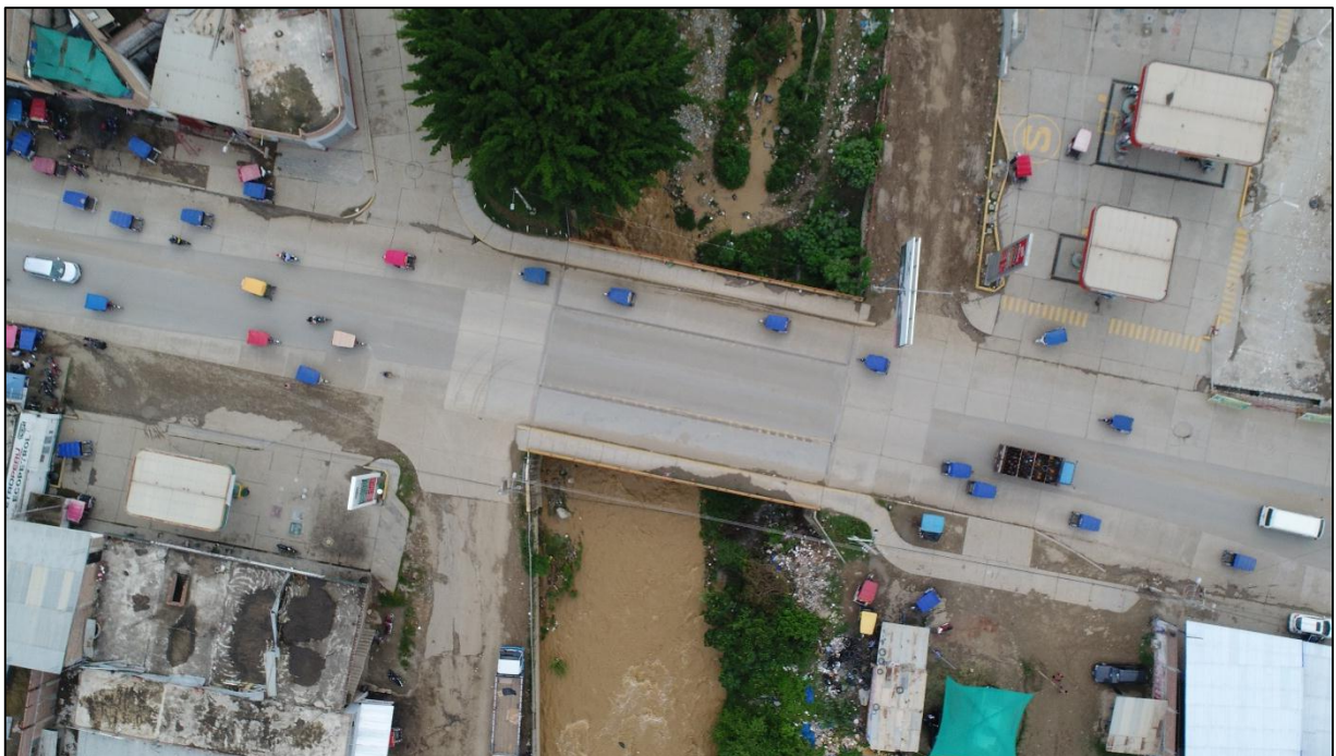
Figura 21. Puente Pakamuros desde una vista aérea
