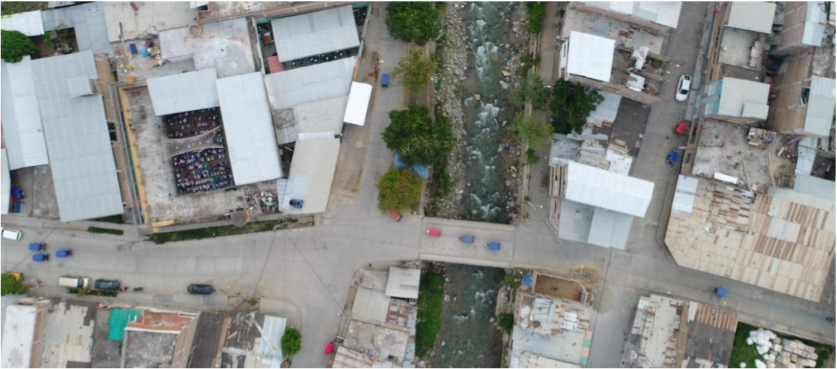
Figura 20. Puente Mesones Muro desde una vista aérea
