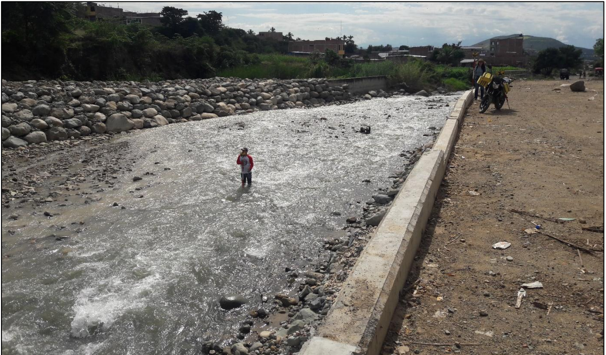
En la imagen se visualiza el trabajo en campo de topografía con Estación total, tomando los puntos de la sección del río Amojú – Sector El Parral. Fuente: Elaboración propia
