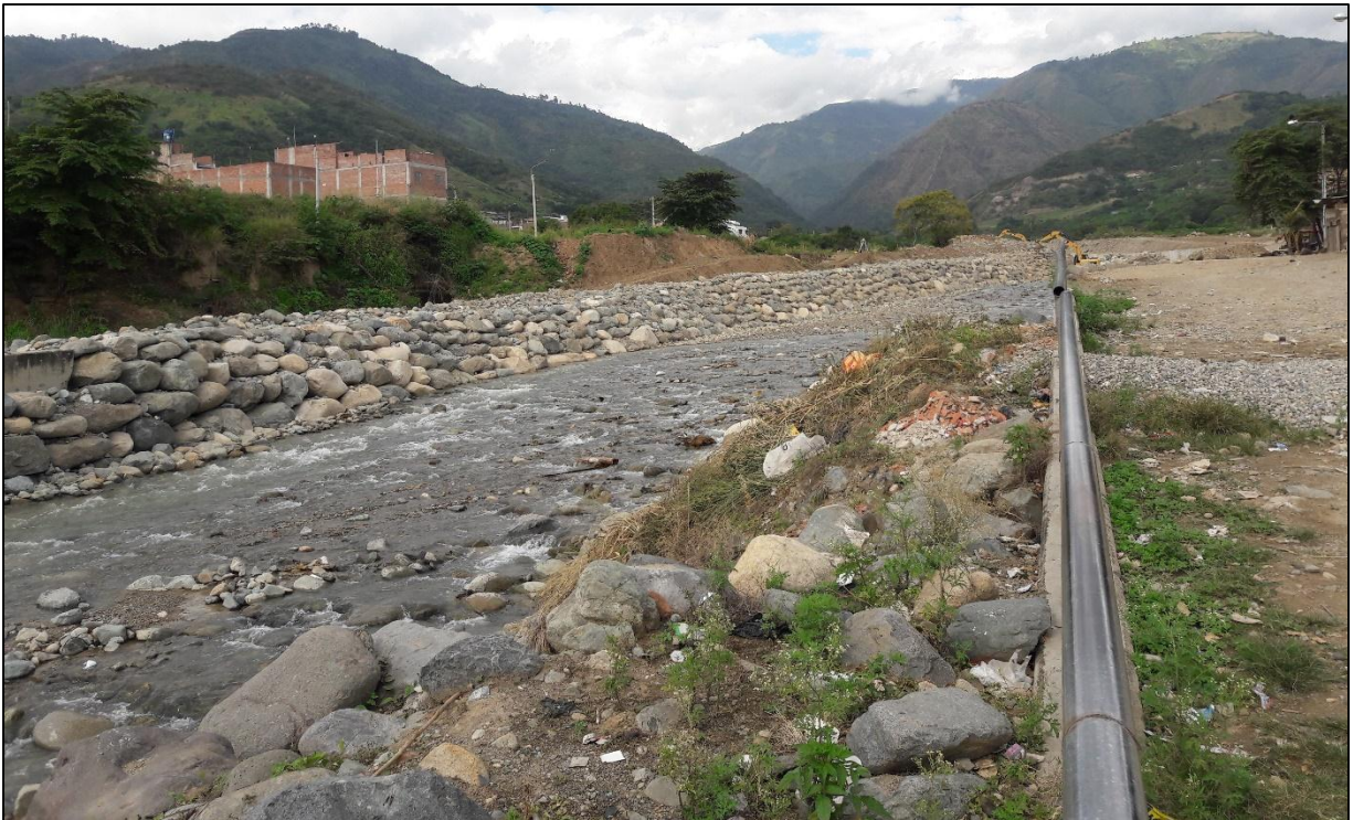
En el Sector El Parral, en último tramo del área de influencia del estudio, cuenta con muro de contención en una margen y la otra margen con un enrocado como defensa ribereña, siendo insignificante la vegetación en el lecho del río. Fuente: Elaboración propia
