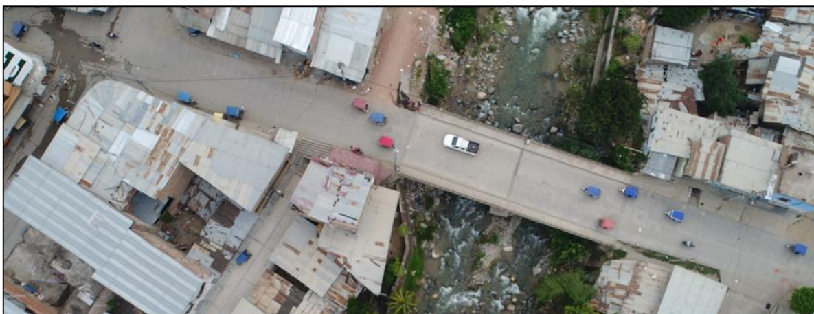
Figura 17. Puente Orellana desde una vista aérea
