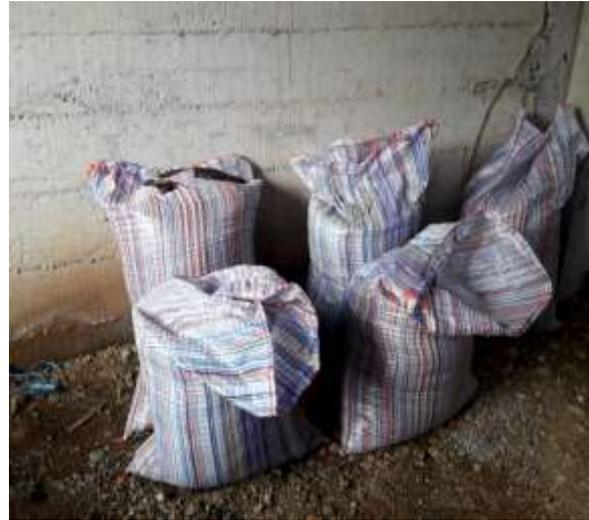
Figura 29. Suelo almacenado en sacos para evitar que se contamine.
