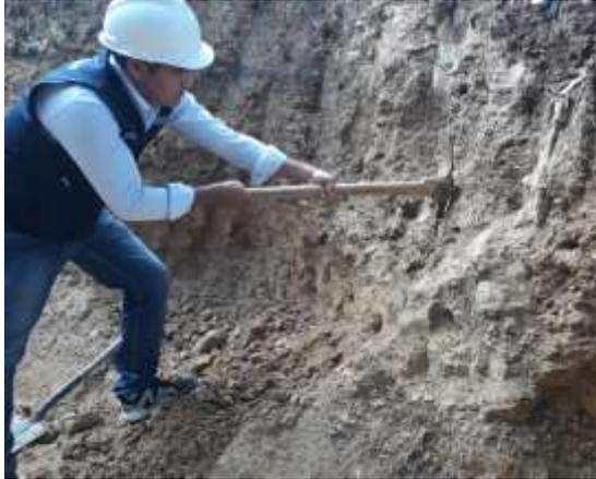
Figura 26. Extracción de suelo de la cantera San Isidro –Jaén para la elaboración de adobes.
