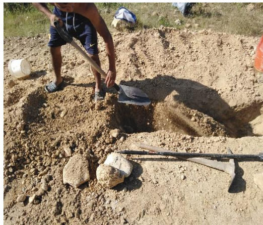
Figura 8. Excavación de la Calicata
