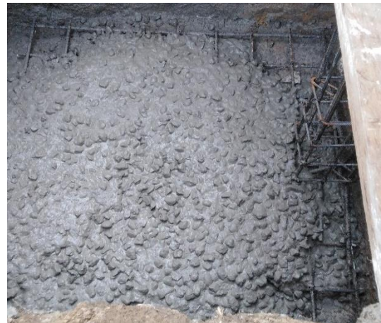
Figura 93. Colocación de concreto
