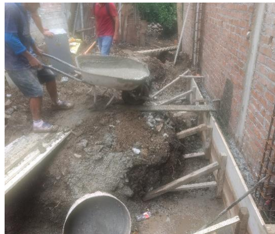
Figura 177. Colocación de concreto.
