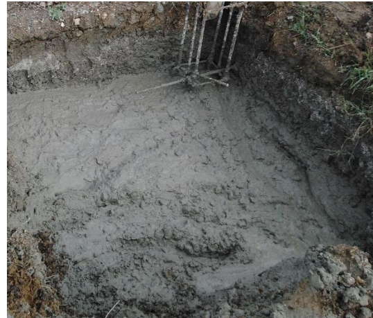
Figura 81. Colocación de concreto.
