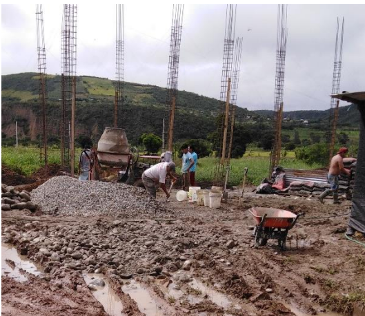
Figura 152. Elaboración de concreto.
