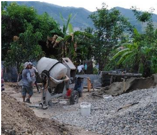
Figura 92. Elaboración de concreto.
