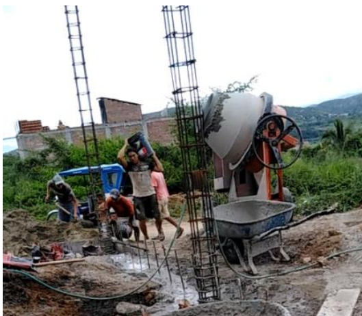
Figura 116. Elaboración de concreto.
