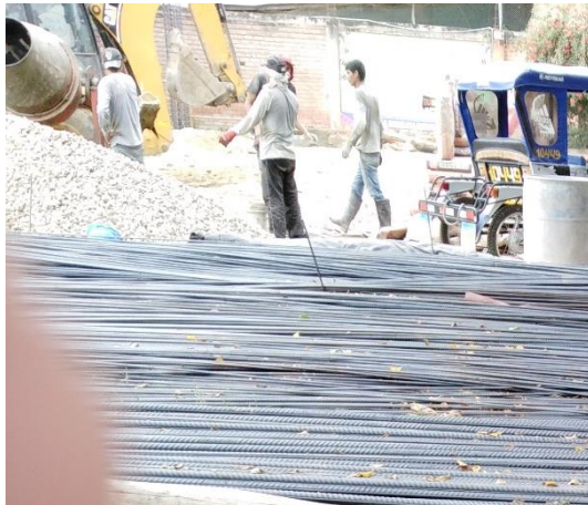
Figura 68. Elaboración de concreto.
