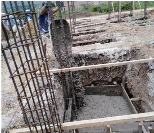
Figura 12. Proceso de colocación del concreto. Figura 13. Proceso de vibración del concreto
