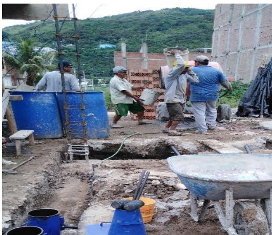
Figura 104. Elaboración de concreto.
