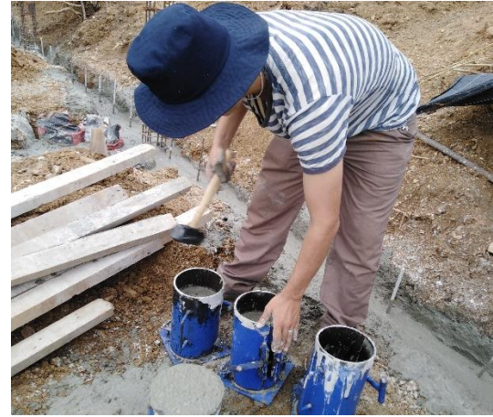
Figura 22. Figura 23. Elaboración de testigos de concreto.
