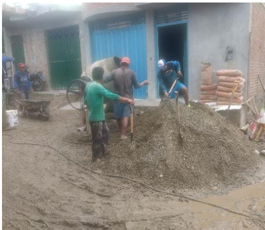
Figura 80. Elaboración de concreto
