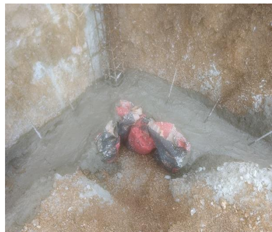
Figura 117. Colocación de concreto
