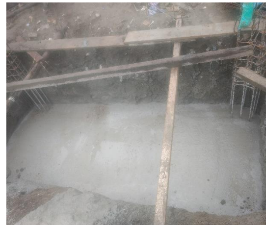
Figura 141. Colocación de concreto
