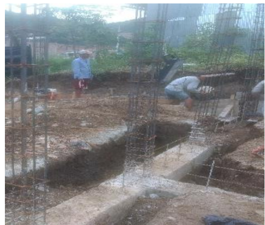
Figura 105. Colocación de concreto
