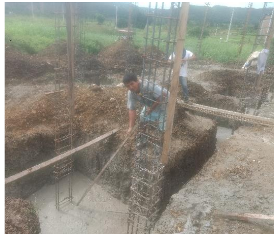
Figura 153. Colocación de concreto
