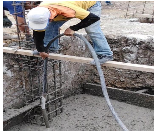
Figura 12. Proceso de colocación del concreto. Figura 13. Proceso de vibración del concreto
