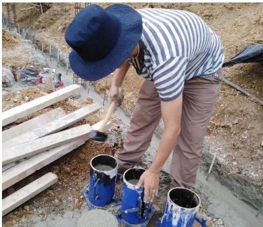
Figura 122. Elaboración de testigos de concreto. Figura 123. Curado de testigos de concreto.
