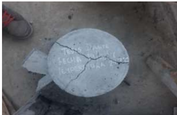
Ilustración 2: Falla del concreto
