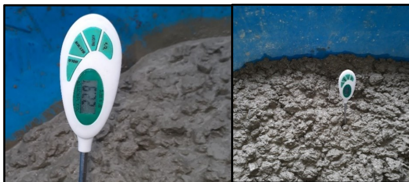
Figura 27. Medición de la temperatura del concreto fresco.
