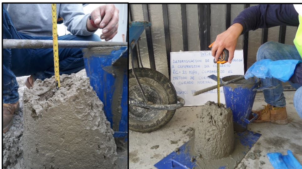
Figura 24. Ensayo de trabajabilidad del concreto fresco – Slump.
