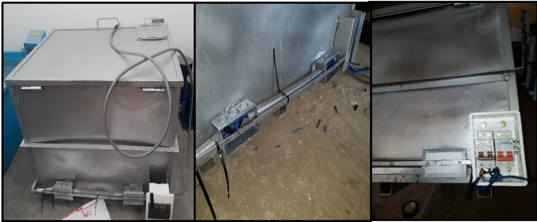
Figura 8. Instalaciones eléctricas internas del tanque de curado acelerado.
