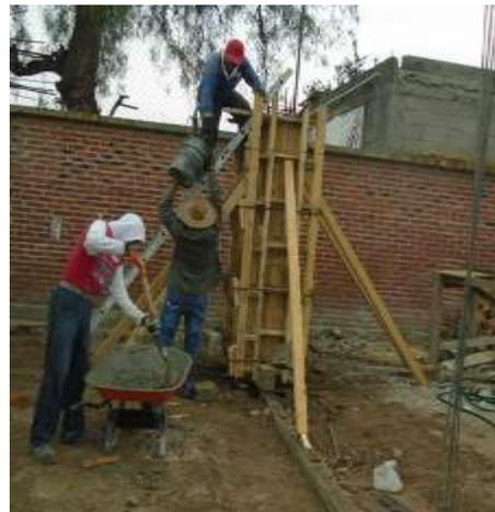
*Figura 13. Colocado de concreto*      *Figura 14. Colocación del concreto*
