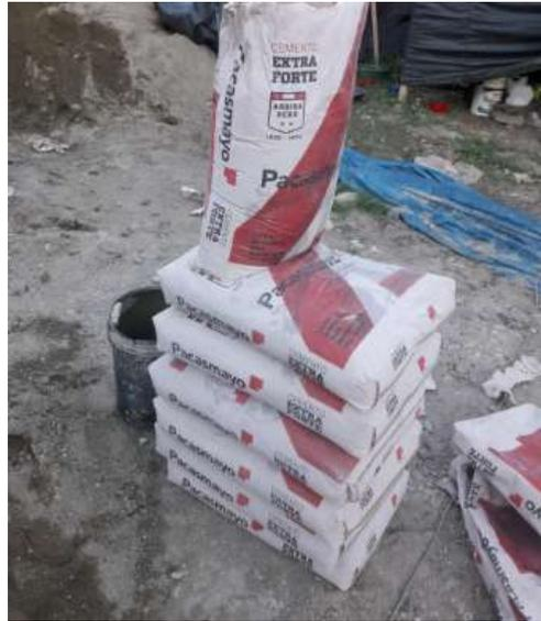
*Figura 6.apilado de cemento    Figura 5. . Condiciones de almacenamiento del cemento*
