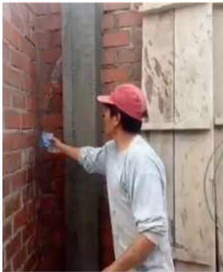
*Figura 15. Curado del concreto.*
