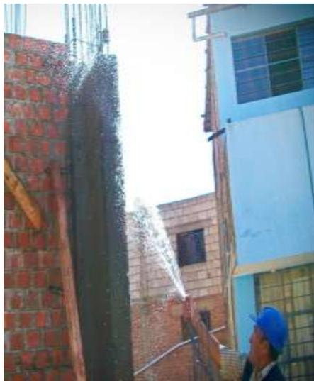
*Figura 16. Curado de concreto*
