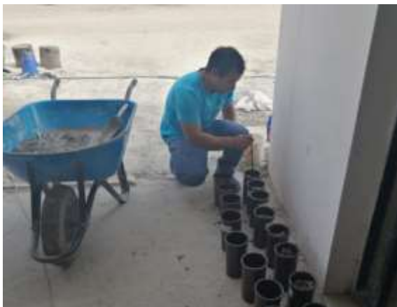
Foto 47. Llenado y varillado de testigos
