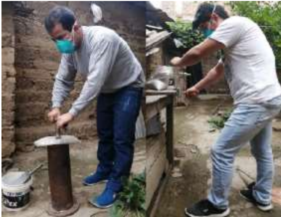
Foto 35. Trituración manual del vidrio
