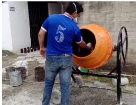
Foto 38. Preparación de concreto
