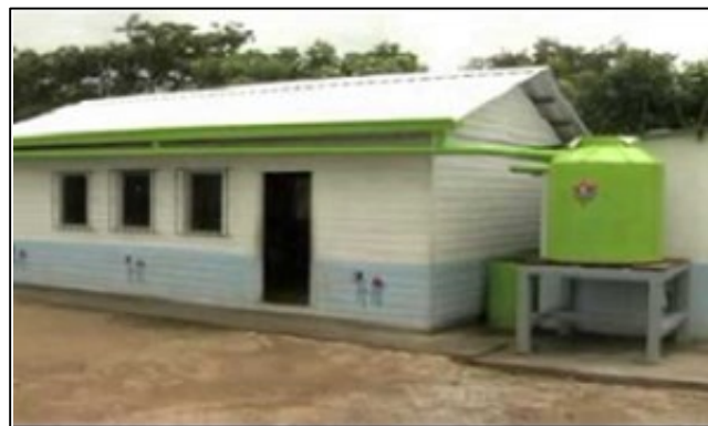
Figura N° 25. Sist. de aprovechamiento de agua pluvial con tanque de almacenamiento sobre la superficie.
