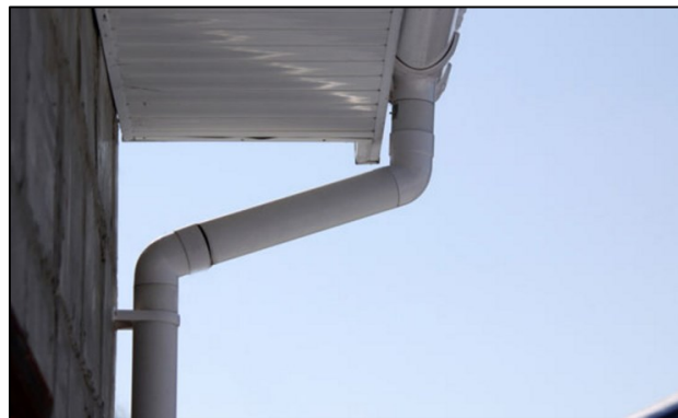
Figura N° 29. Unión de la canaleta con la montante para la conducción de las aguas pluviales. Fuente: Elaboración propia.
