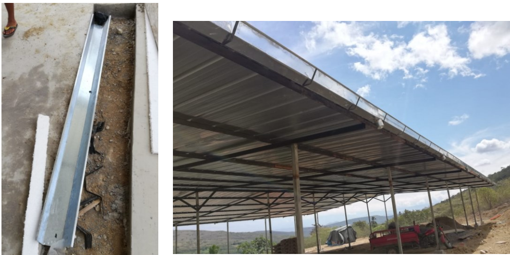
Figura N° 50. Canaletas metálicas de aluminio utilizadas en una cobertura para granja en Bagua Grande.
