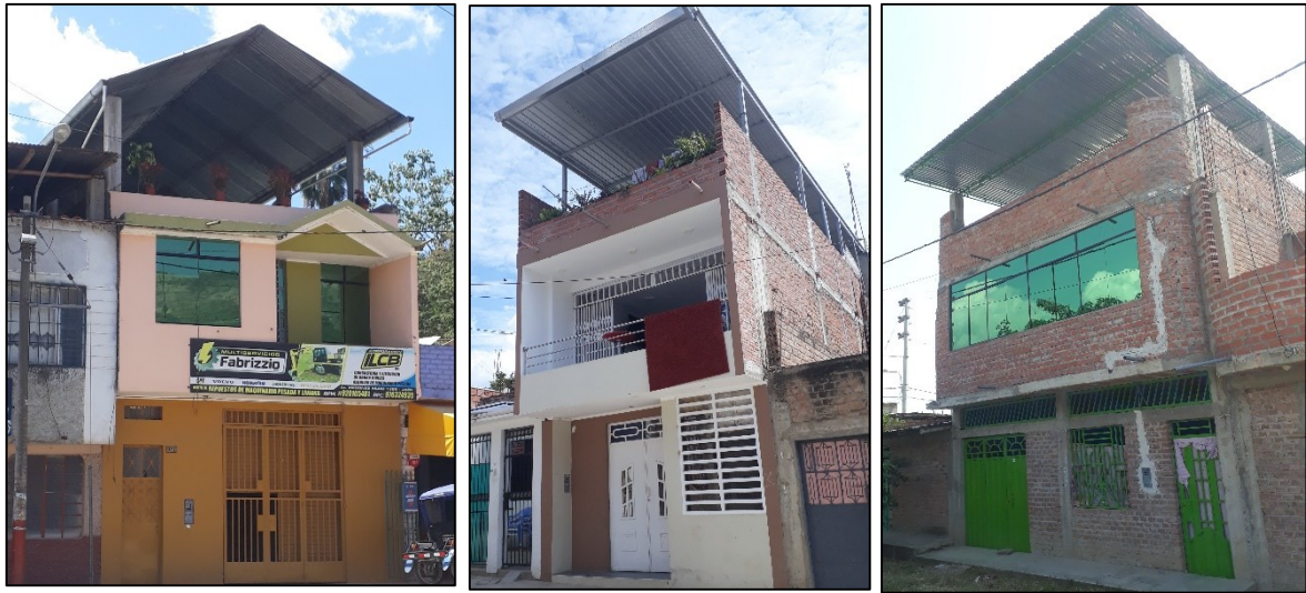
Figura N° 46 Fotografías de viviendas con cubierta superior en los diferentes sectores de Jaén. Fuente: Elaboración propia.
