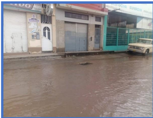
Figura N° 20 : Colapso del sistema de drenaje, e inundación de la avenida Mesones Muro, a causa de las fuertes precipitaciones.
