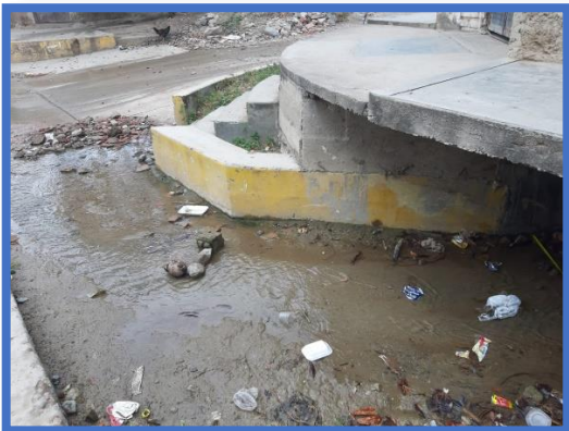
Figura N° 34: Desembocadura de las aguas recolectadas en el sistema drenaje, las cuales terminan en calles de la parte baja.
