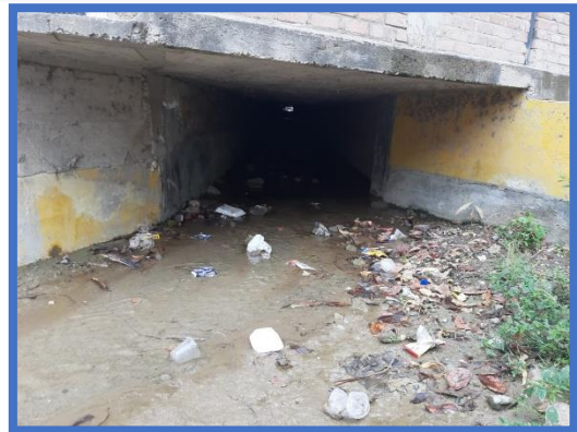
Figura N° 34: Desembocadura de las aguas recolectadas en el sistema drenaje, las cuales terminan en calles de la parte baja.
