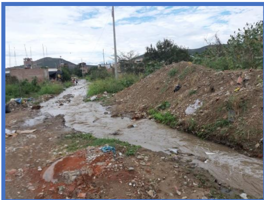
Figura N° 34: Desembocadura de las aguas recolectadas en el sistema drenaje, las cuales terminan en calles de la parte baja.
