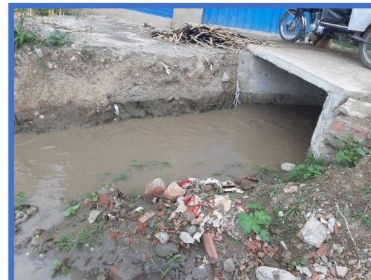
Figura N° 34: Desembocadura de las aguas recolectadas en el sistema drenaje, las cuales terminan en calles de la parte baja.
