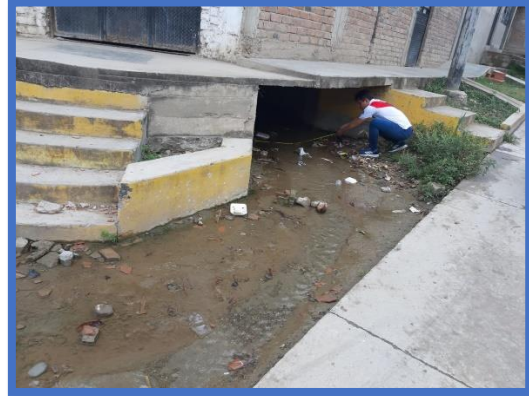
Figura N° 33: Desembocadura de la subcuenca N°1, la cual aporta caudal al sistema de drenaje en épocas de máximas precipitaciones
