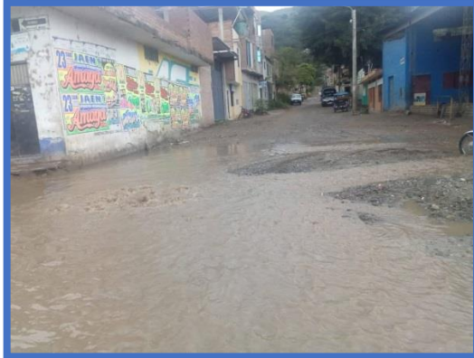
Figura N° 20 : Colapso del sistema de drenaje, e inundación de la avenida Mesones Muro, a causa de las fuertes precipitaciones.
