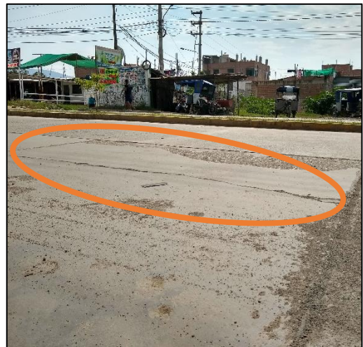
Figura 23. Figura 24. Falla-grietas longitudinales y transversales en pavimento rígido.
