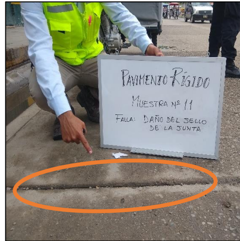
Figura 21. Figura 22. Falla-daño al sello de junta en pavimento rígido.
