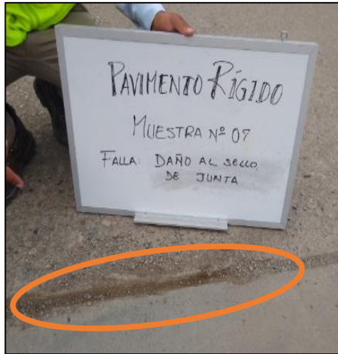
Figura 21. Figura 22. Falla-daño al sello de junta en pavimento rígido.
