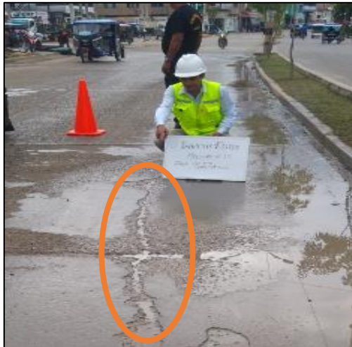
Figura 23. Figura 24. Falla-grietas longitudinales y transversales en pavimento rígido.
