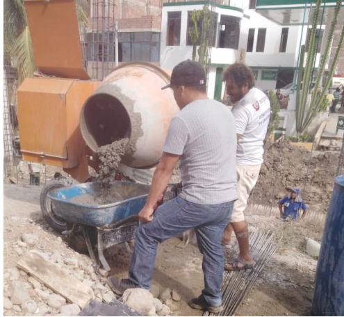
Figura 9. Figura 10. Extracción de muestras de concreto elaborado sin aditivo.
