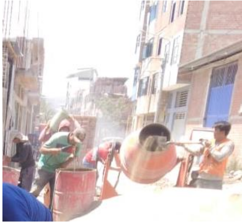
Figura 5. Figura 6. Elaboración de concreto sin aditivo.
