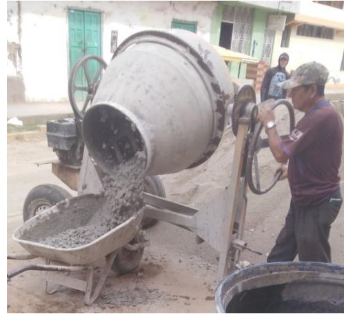
Figura 9. Figura 10. Extracción de muestras de concreto elaborado sin aditivo.
