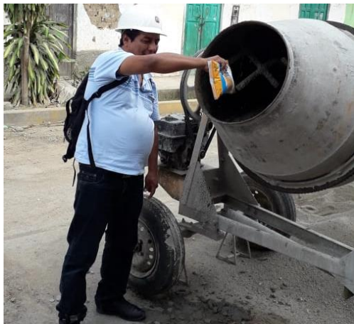
Figura 7. Figura 8. Elaboración de concreto con aditivo SikaCem Plastificante en polvo.
