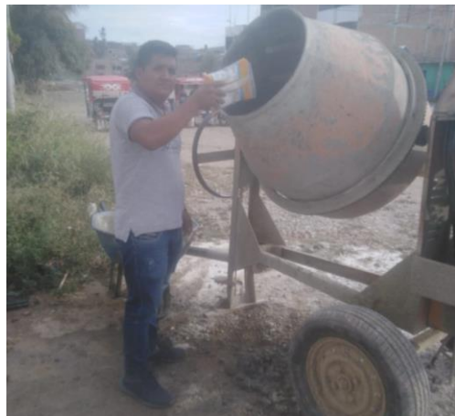
Figura 7. Figura 8. Elaboración de concreto con aditivo SikaCem Plastificante en polvo.
