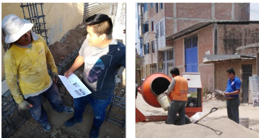
Figura 39. Figura 40. Difusión de resultados obtenidos entre los encargados de obra sobre ventajas y desventajas que ofrece el aditivo SikaCem plastificante en polvo.
