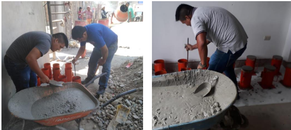
Figura 19. Figura 20. Elaboración de testigos de concreto con aditivo SikaCem plastificante en polvo.
