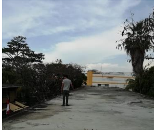
Figura 43. Inspección de losa aligerada (módulo 03).
