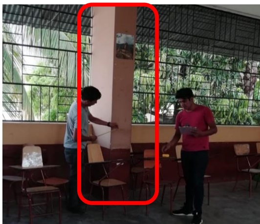
Figura 16. Medición de columna (Módulo 01 primer piso).
