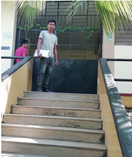
Figura 34. Escalera de módulo 03
