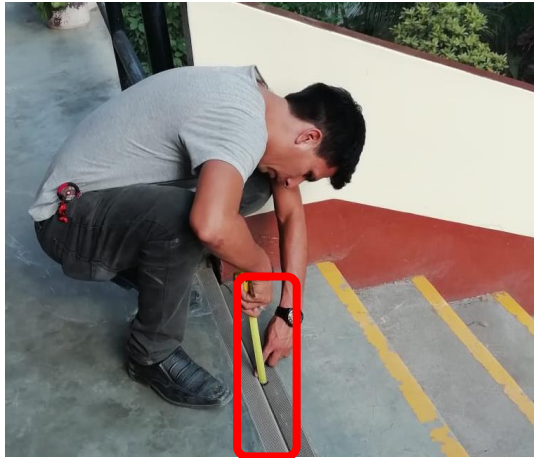
Figura 26. Figura 27. Escalera con deficiencias en su conexión que conecta el módulo 1 con el módulo 2.
