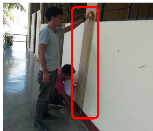
Figura 17. Medición de columna (Módulo 01 primer piso).
