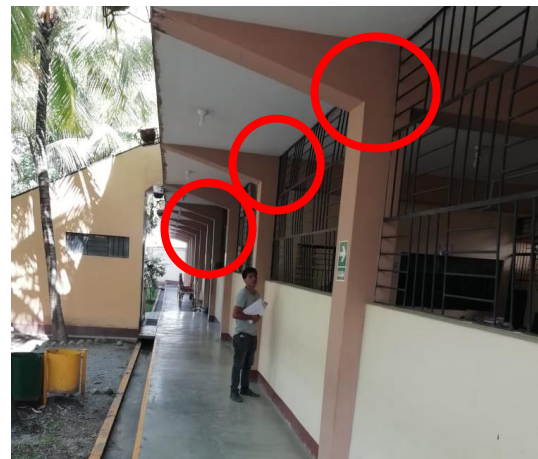
Figura 24. Figura 25. Conexión entre el diafragma y elementos estructurales es eficaz (módulo 3)
