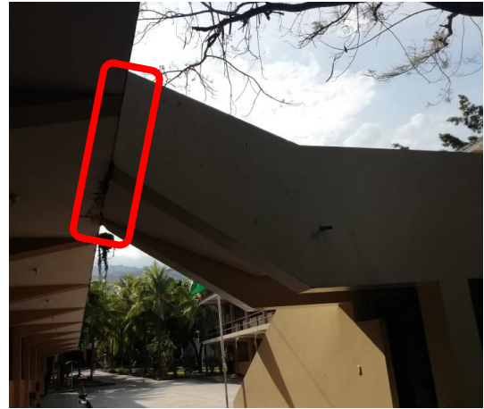
Figura 26. Figura 27. Escalera con deficiencias en su conexión que conecta el módulo 1 con el módulo 2.
