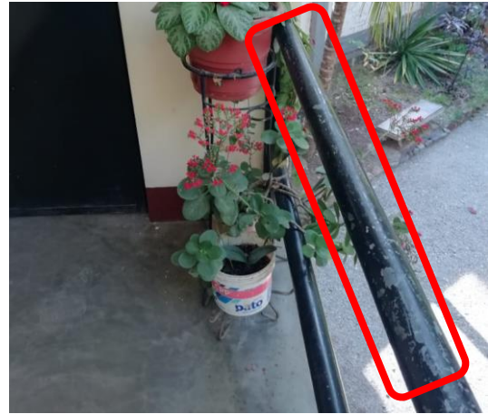
Figura 23. Pasamanos del módulo 03 (segundo piso).
