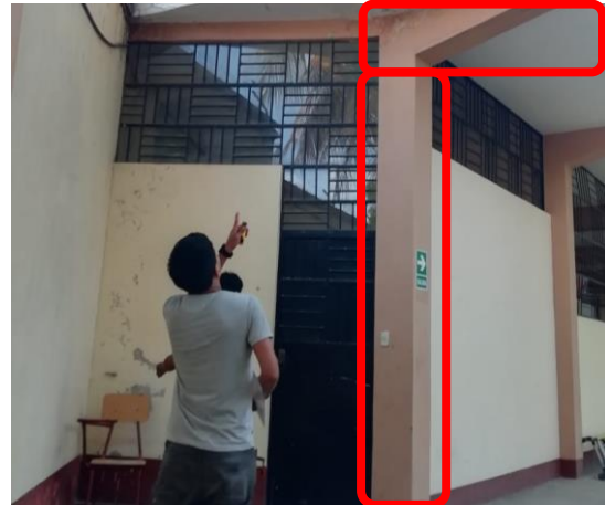
Figura 15. Columnas y vigas de concreto armado
