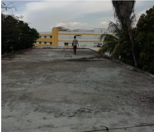
Figura 18. Cobertura de losa aligerada de concreto armado de módulo 03.
