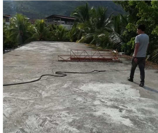
Figura 19. Cobertura de losa aligerada de concreto armado de módulo 03.
