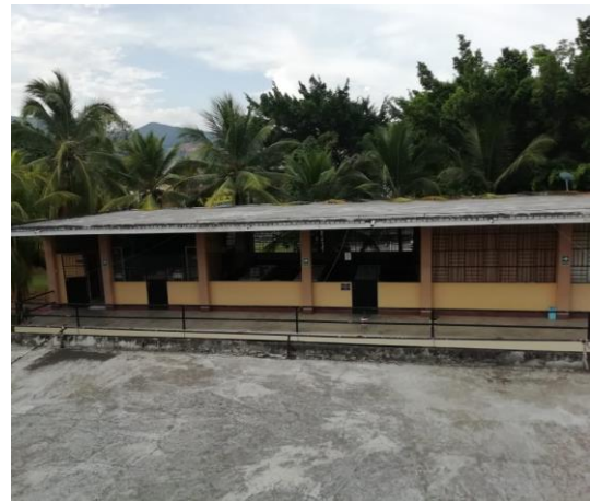
Figura 45. Inspección de losa (módulo 02)
