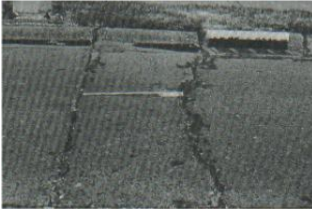
Fig. 35: Punzonamiento de severidad leve
