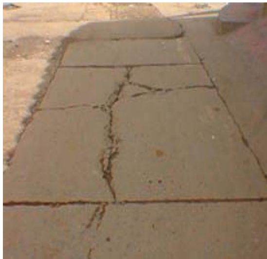
Fig. 56: Losas Subdivididas
