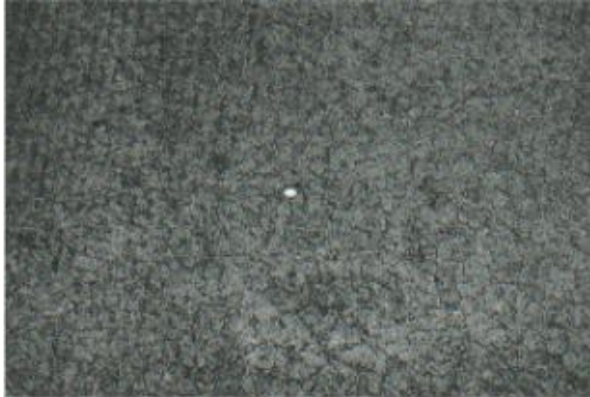
Fig. 39: Desconchamiento / Craquelado de severidad leve
