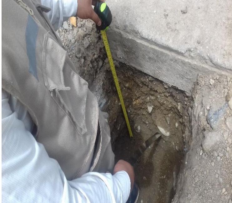
Fig. 62: Capas de la vía de Pavimento Rígido
