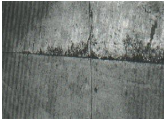
Fig. 51: Descascaramiento de junta de severidad alta
