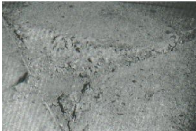
Fig. 47: Descascaramiento de esquina de severidad alta
