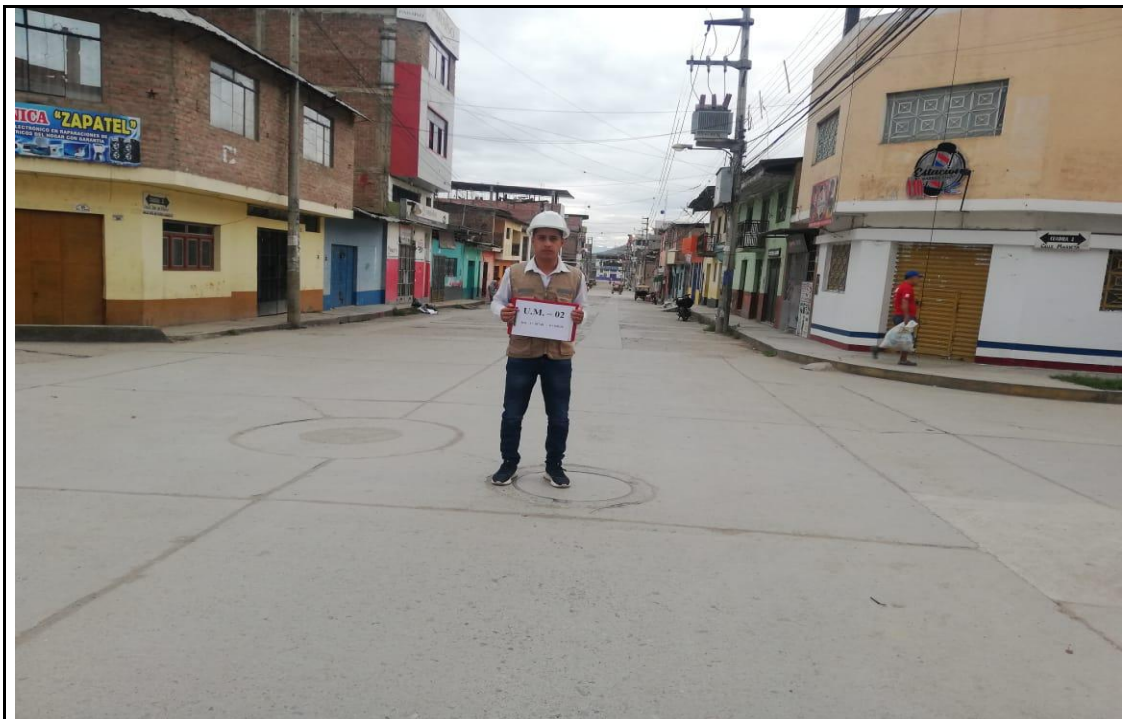
Foto 2. UNIDAD DE MUESTRA N° 02: Ubicado en la calle Dos de Mayo en la progresiva Km 0+047.48 al Km 0+090.26 , en la Cuadra N° 02; conformado por los paños del 21 al 40 (izquierda y derecha). En la U.M. N° 02 presenta fallas de: Grietas de Esquina (22) de Severidad Media, Losa Divida (23) de Severidad alta, Grietas Lineales (28) de Severidad Media , Parche Grande (29) de Severidad Media y Grietas de Retracción (37) de Severidad Leve
