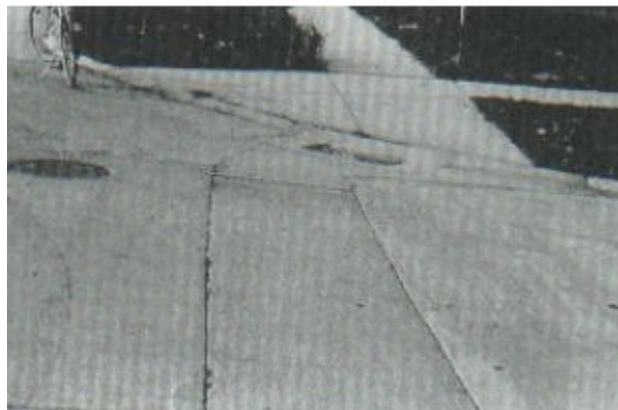
Fig. 23: Parche grande de leve severidad
