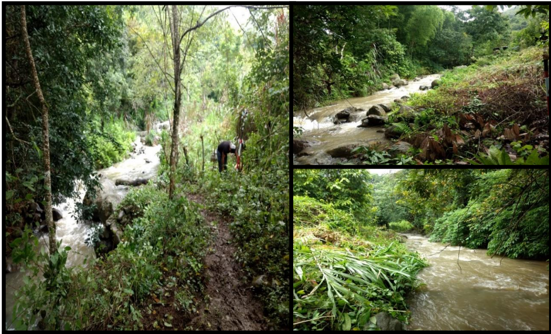
FOTO 3: VISTA DE LA QUEBRADA BOMBOCA, DONDE SE CONSTRUIRÁ PROTECCIÓN CONTRA INUNDACIONES CON ROCAS AL VOLTEO EN LA PROGRESIVA.
