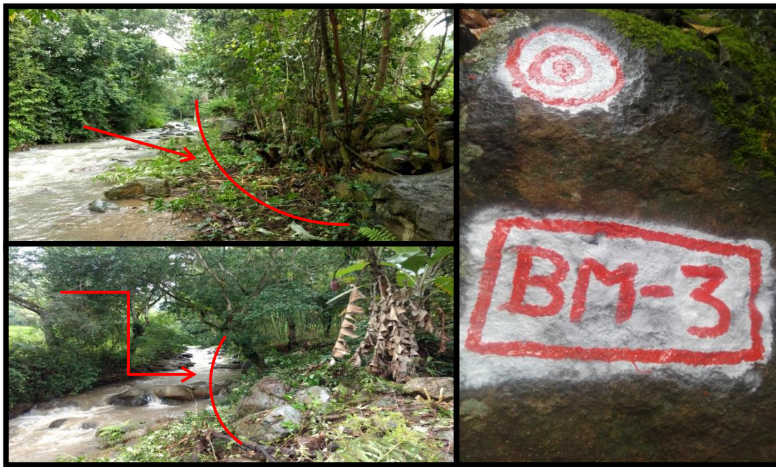
FOTO 5: VISTA DE LA QUEBRADA BOMBOCHA, DONDE SE CONSTRUIRÁ PROTECCIÓN CONTRA INUNDACIONES CON ROCAS AL VOLTEO, Y TAMBIÉN SE APRECIA EL PUNTO DE REFERENCIACIÓN (BM - 3).
