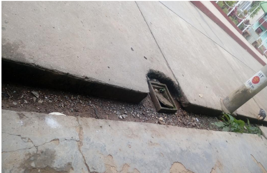
Figura 34. Conexiones domiciliarias en San José del Alto.
