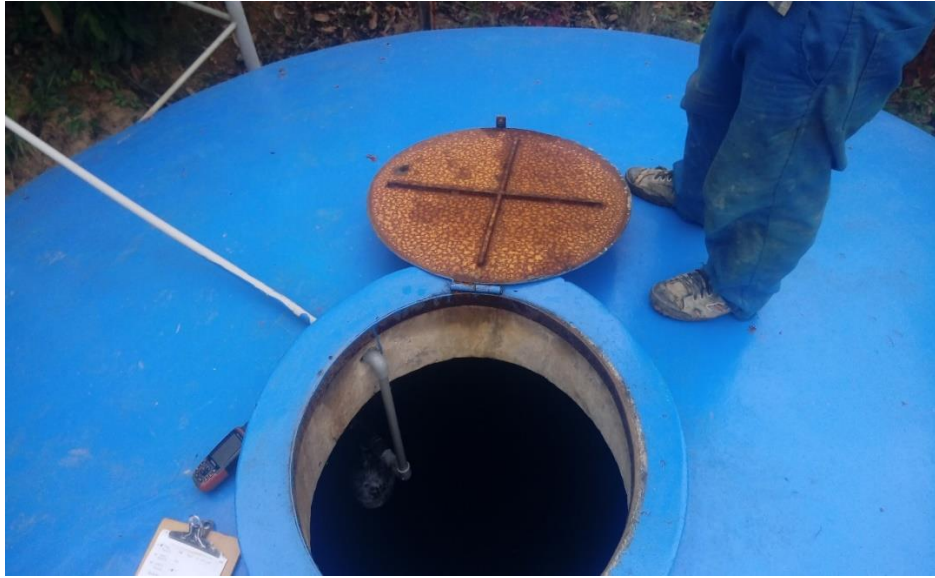
Figura 13. Condición del reservorio.
