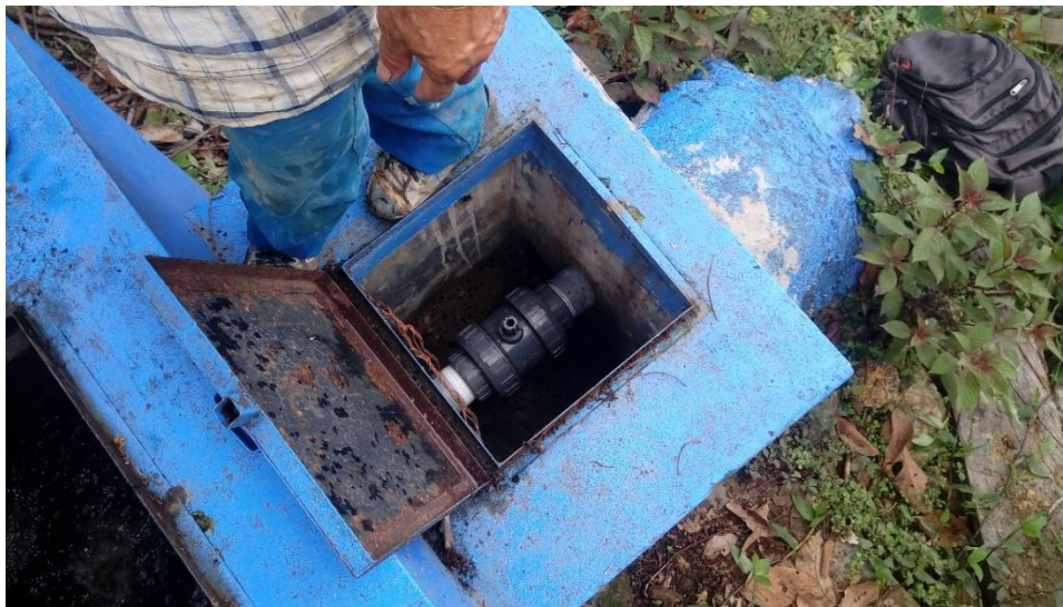
Figura 5. Válvula de compuerta.
