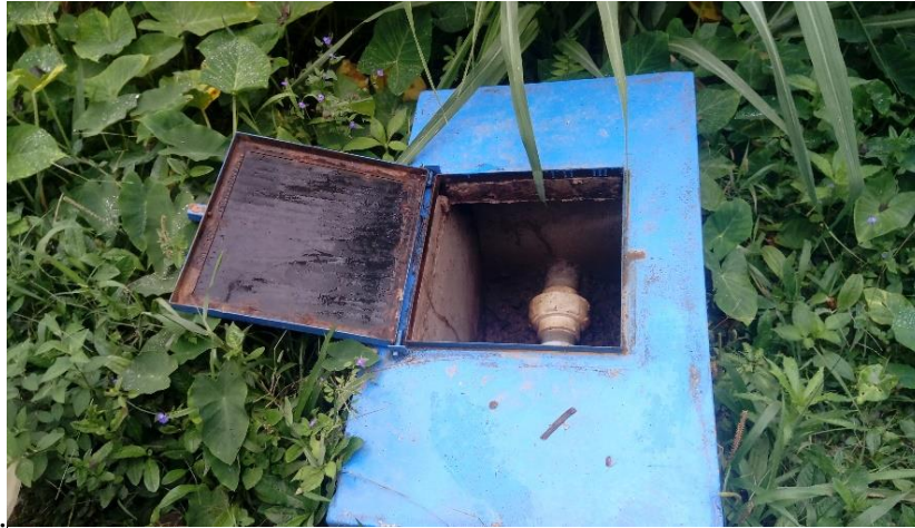
Figura 10. Válvula de purga en línea de conducción.
