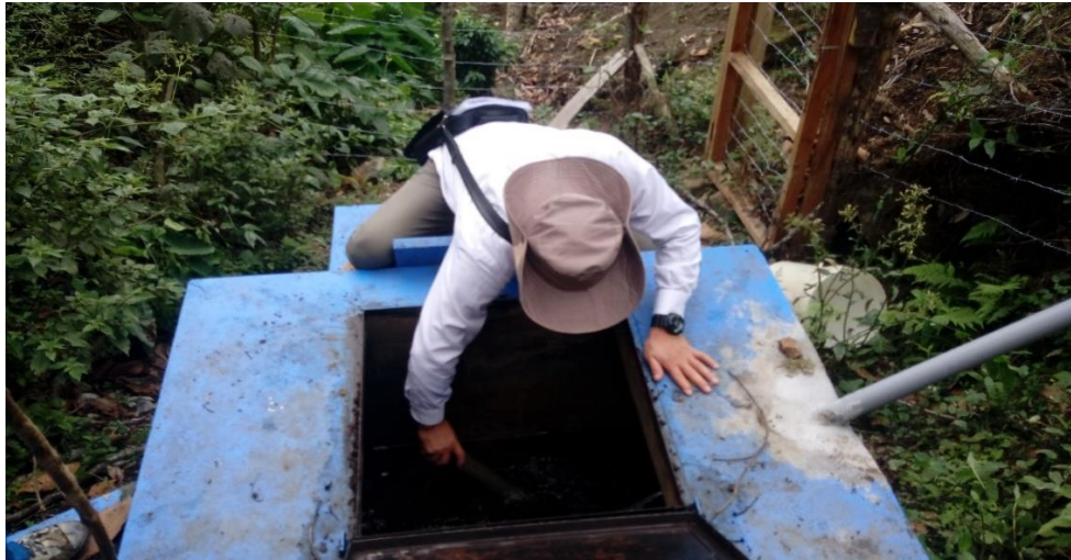
Figura 8. Cercado de Sistema de captación.
