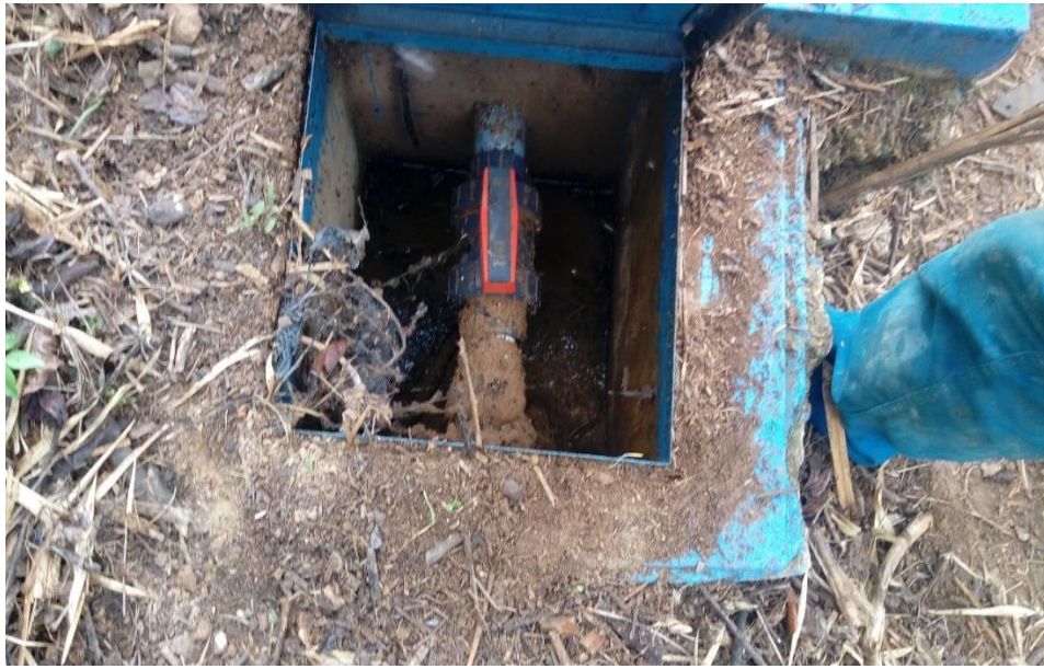
Figura 25. Llave de control con filtraciones y otras impurezas.
