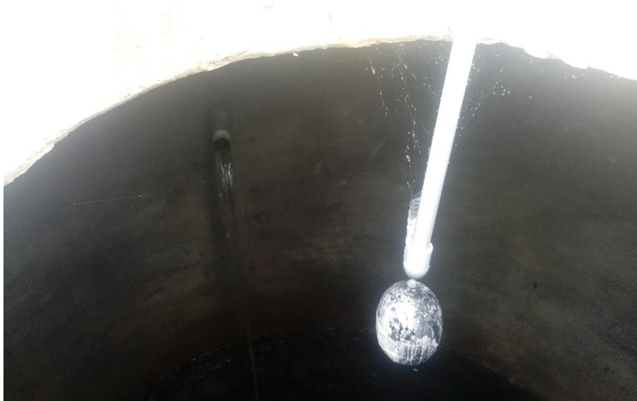
Figura 12. Boya con restos de la cloración incompleta al reservorio.
