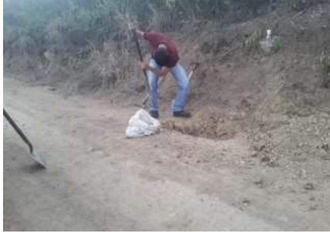
Figura 13: Excavación de Calicata.
