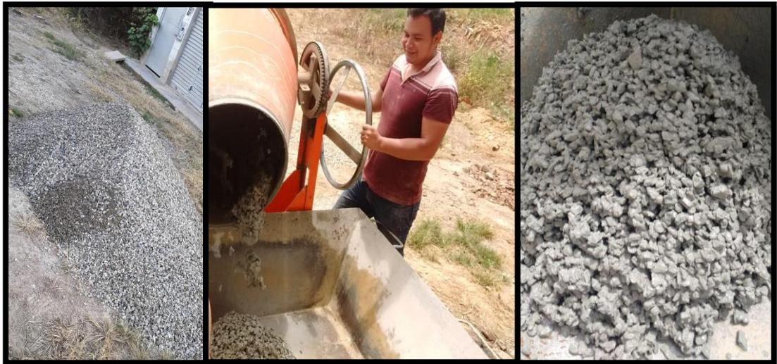
*Figura N° 19.* Elaboración de concreto poroso
