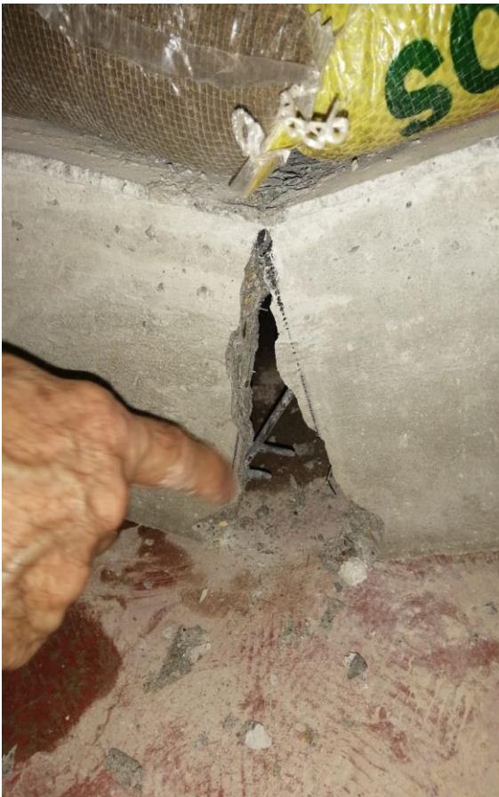
ROTURA DEL PANEL
