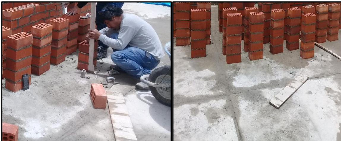
Foto 23 y 24: Control de verticalidad y tamaño de junta en pilas de albañilería.
