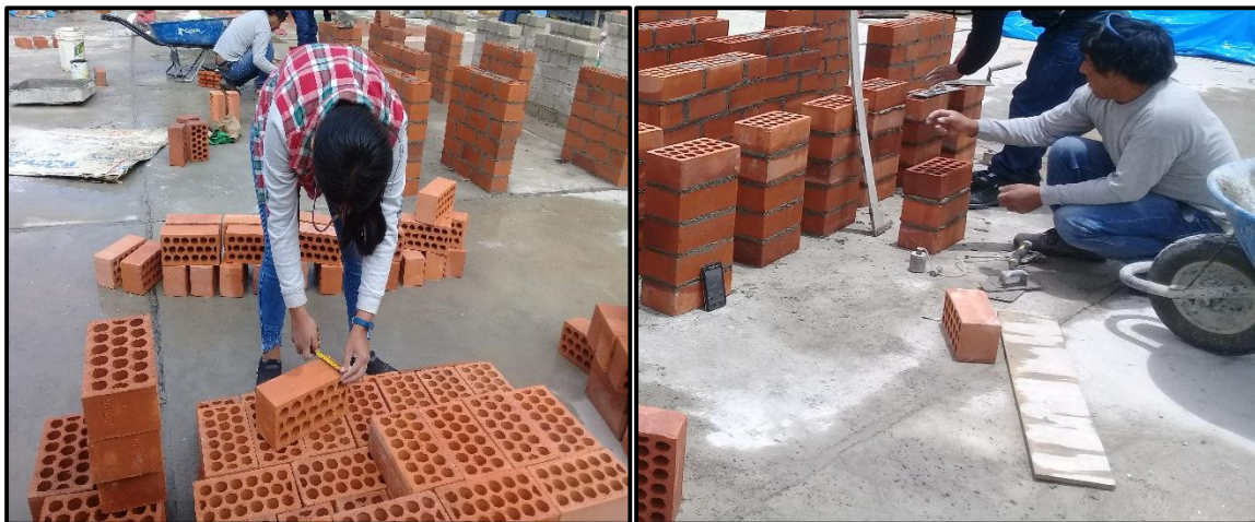
Foto 23 y 24: Control de verticalidad y tamaño de junta en pilas de albañilería.
