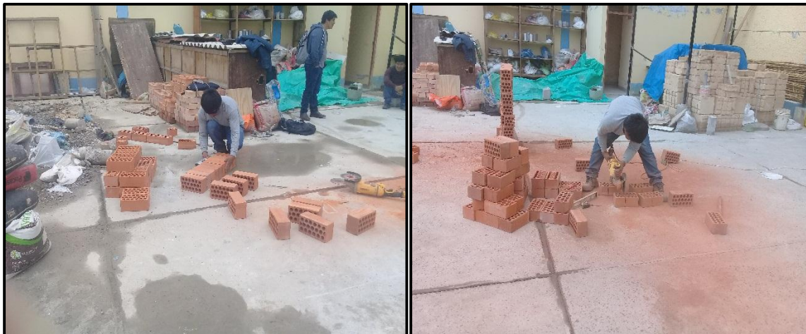
Foto 39 y 40: Construcción de muretes de 62.5x62.5cm de sección y 1.5cm de junta.
