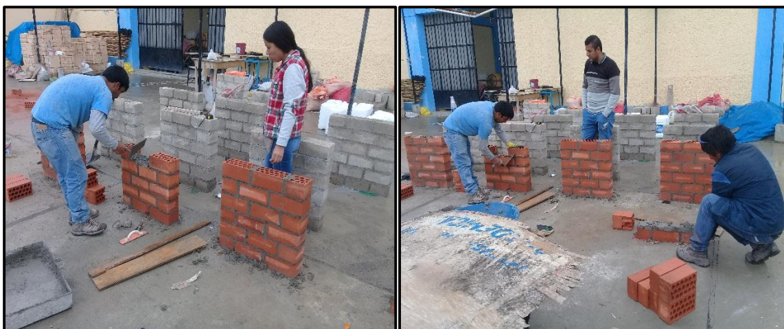
Foto 41 y 42: Control de altura de junta y verticalidad de muretes con y sin adición de cal.
