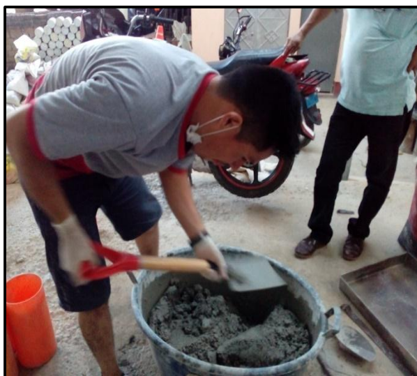
Figura 21: Mezclado de mortero proporción 1:31/2, se toma como medida un balde lleno.
