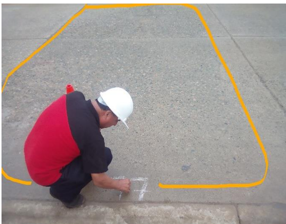
Figure 15. Falla-Pulimiento de agregados
