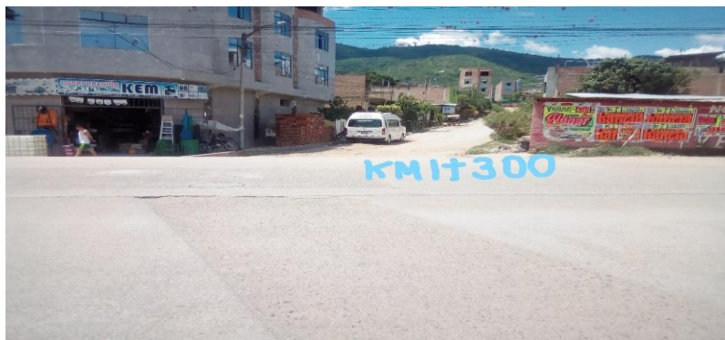
Figura 6. Final de Pavimento Analizado Av. Pakamuros y Calle La Cunia KM 1+300 (Fuente: Elaboración propia).
