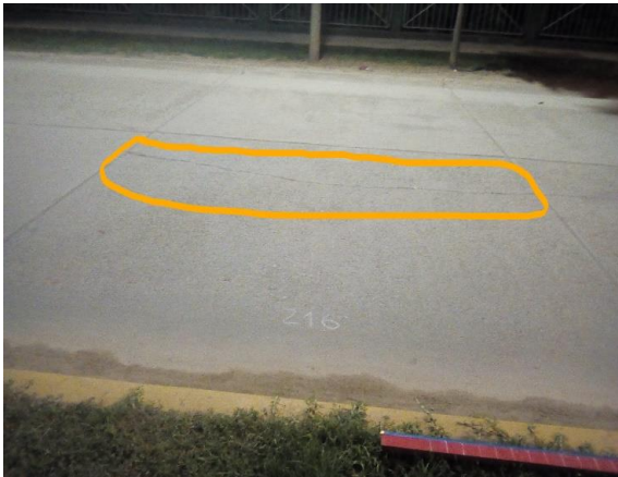
Figure 12. Falla-grieta longitudinal
