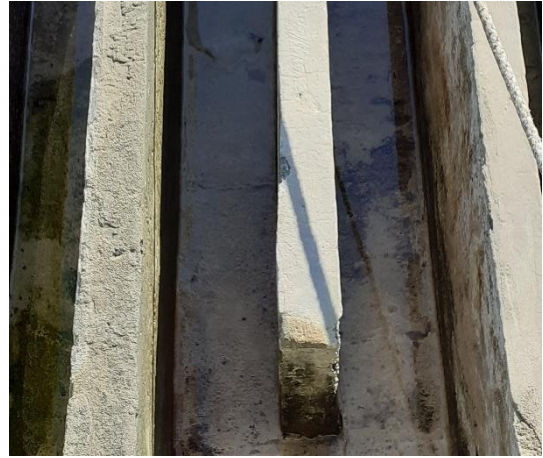
Figura 13: Turbiedad del agua en la entrada a la PTAP.
