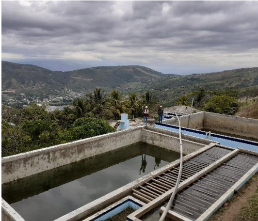
Figura 4: Vista de la Planta de Tratamiento de Agua Potable (PTAP).
