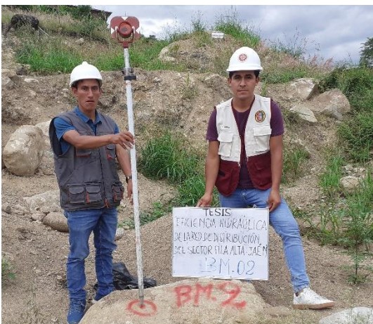
Figura 26: Levantamiento topográfico (Monumentación de BM 2).
