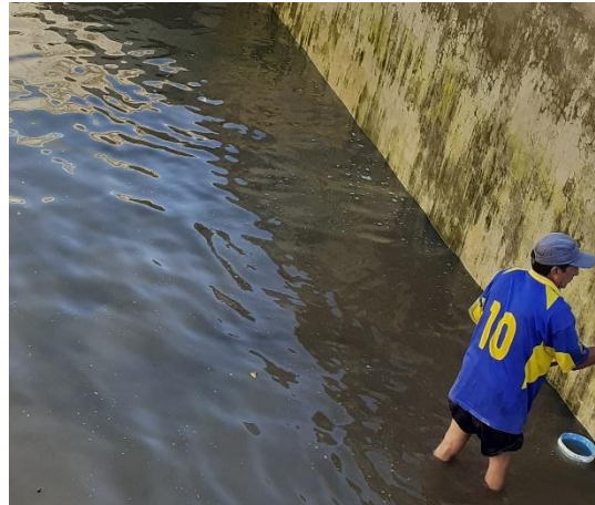
Figura 5: Limpieza realizada a la Planta de Tratamiento de Agua Potable (PTAP).
