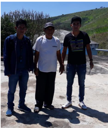
Figura 6: Reservorio rectangular de 372 metros cúbicos de capacidad.
