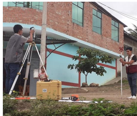
Figura 42: Levantamiento topográfico realizado en el sector Los Olivos.
