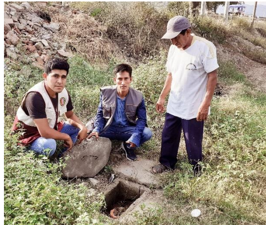
Figura 17: Fuga de agua en válvula de control.
