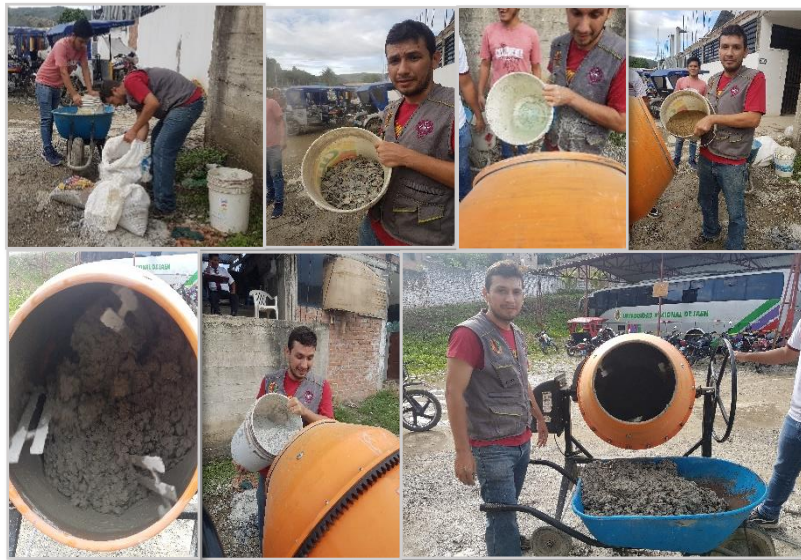
Figura 40. Proceso de elaboración de concreto.
