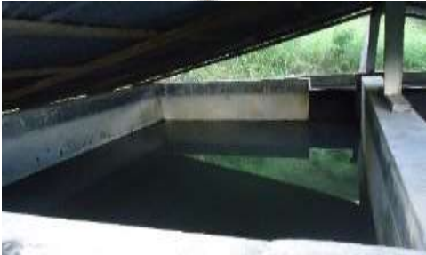
Cámara de Sedimentación
