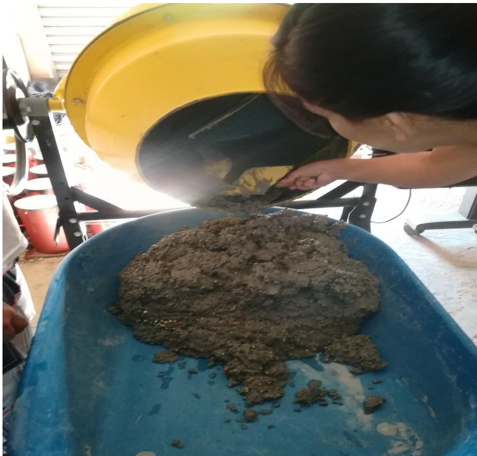
Foto 6. Elaboración de concreto para adoquines de f'c=290 \text{ kg/cm}^2
