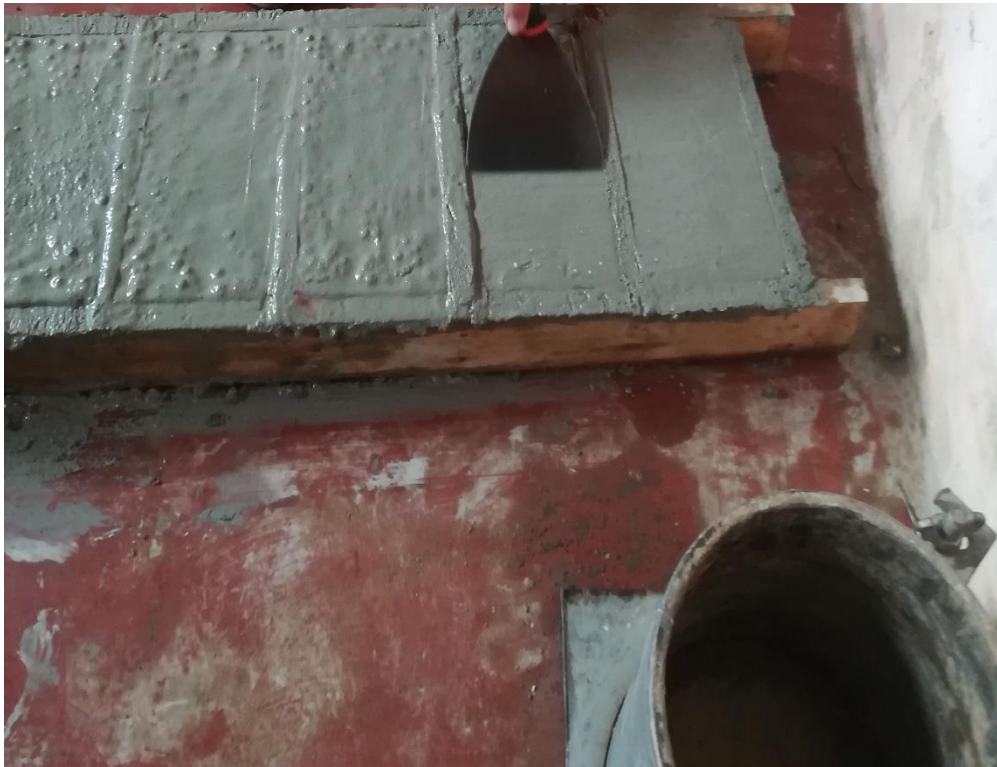
Foto 10. Vaciado de concreto en molde para adoquines
