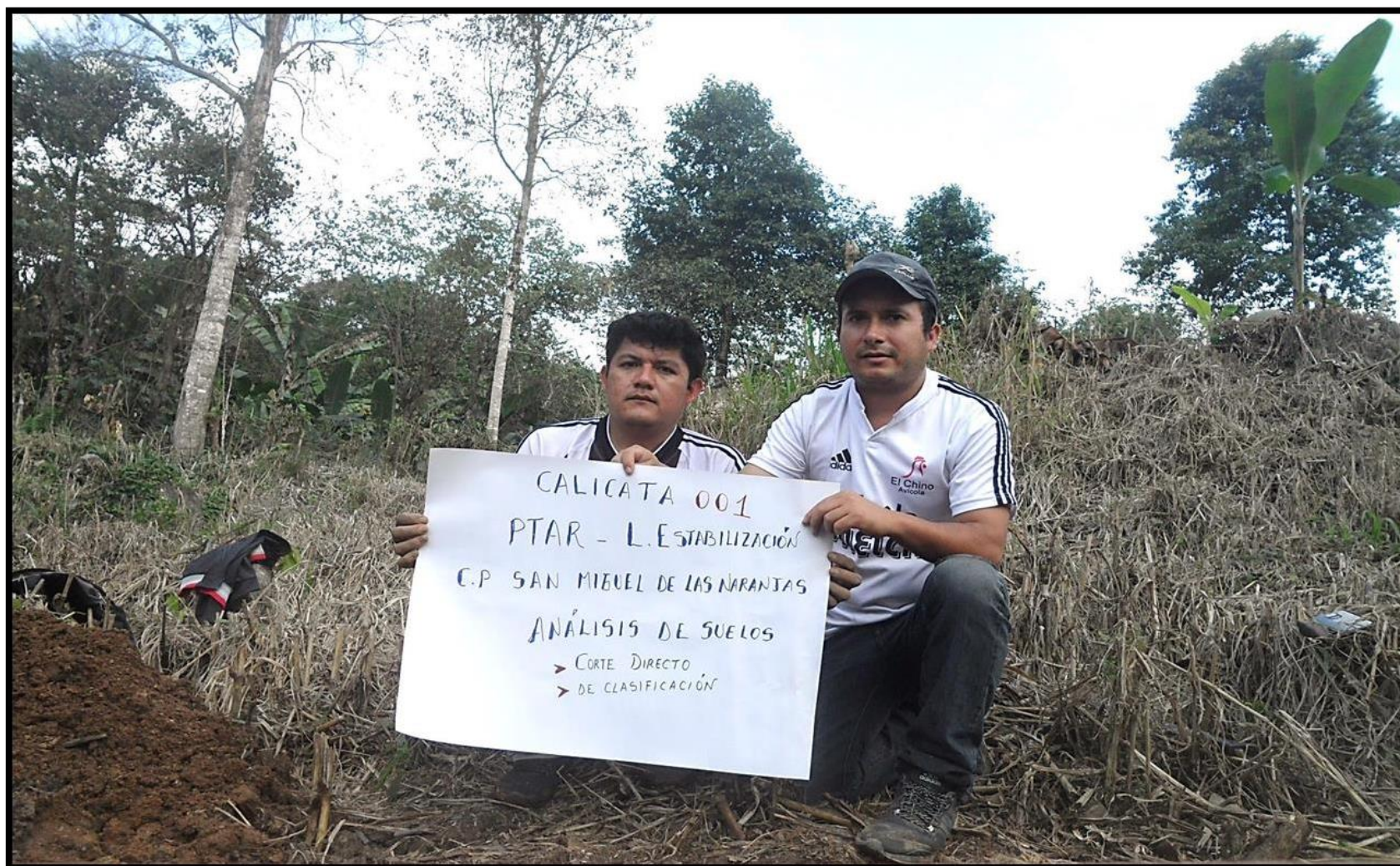
Figura 30. Ejecución de Calicata 001
