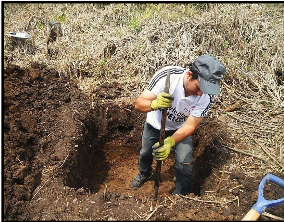
Figura 26. Ejecución de la Calicata 001 - Excavando la tierra
