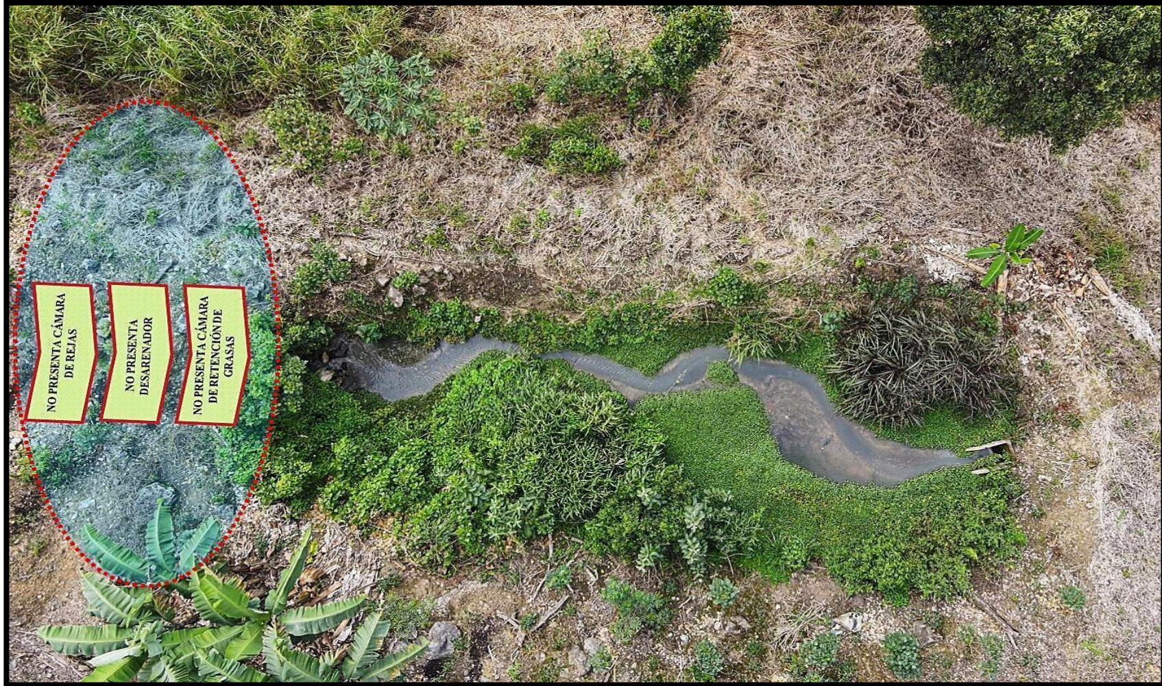
Figura 3. Estado situacional de los componentes en la fase de pretratamiento de las aguas residuales de la poza de oxidación del centro poblado San Miguel de Las Naranjas
