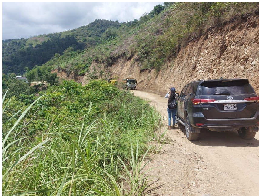
Observación directa en la Obra 6
