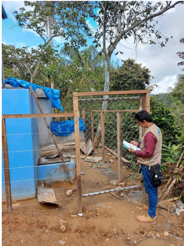
Observación directa en la Obra 5
