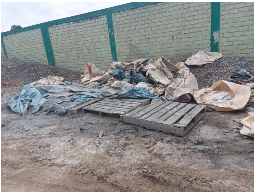
Acumulación de residuos sólidos en la Obra 4
