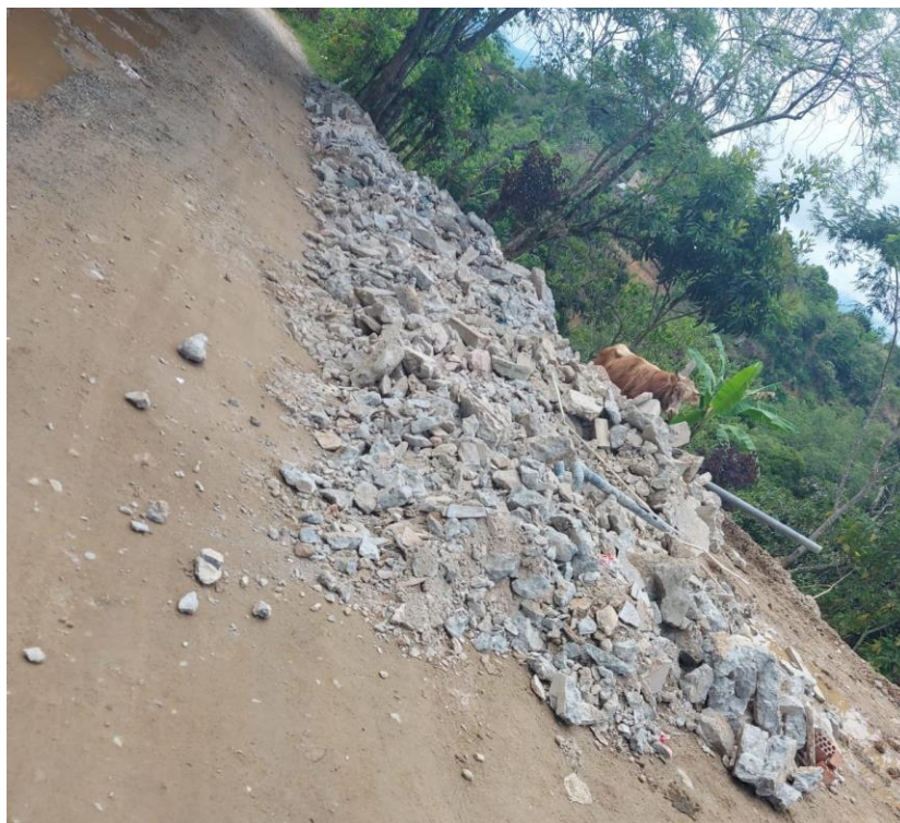
Material excedente en la Obra 2
